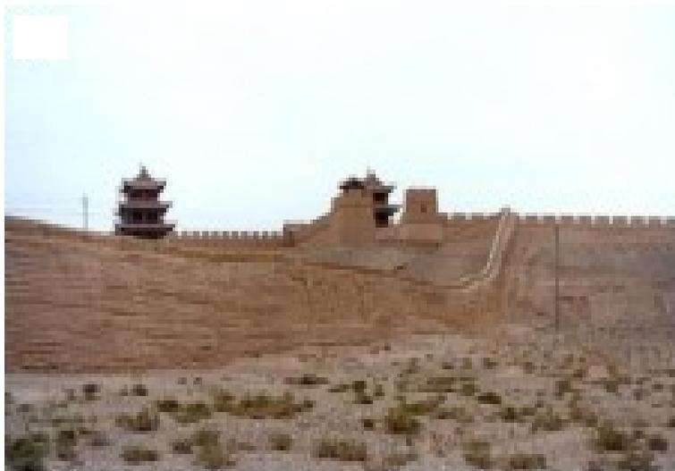
**Figure 1-14 Les tronçons en pisé de la Muraille de Chine (10)**
