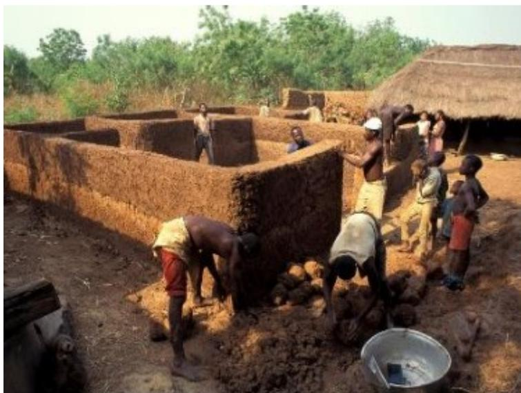
**Figure 1-13 Construction d'une maison en bauge (Bénin) (10)**
