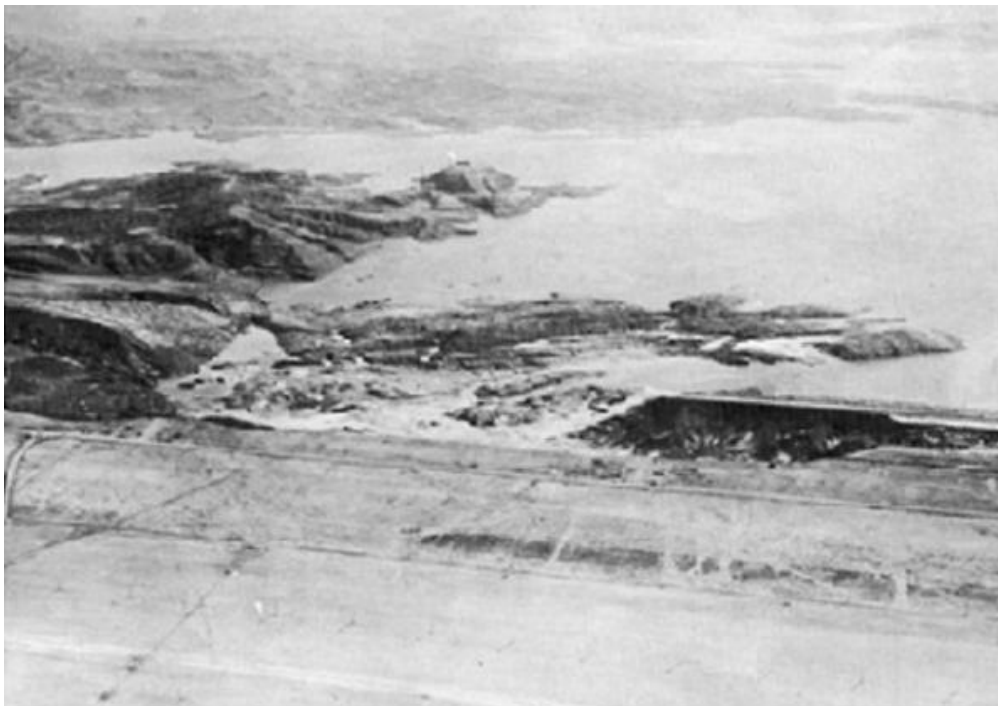
Figure 1. 2: Vue aérienne de la rupture de barrage de Fort Peck( corps de l'armée des Etats Unis d'Ingénieurs,1939,(MikeJefferies et Ken Ben,2006)
