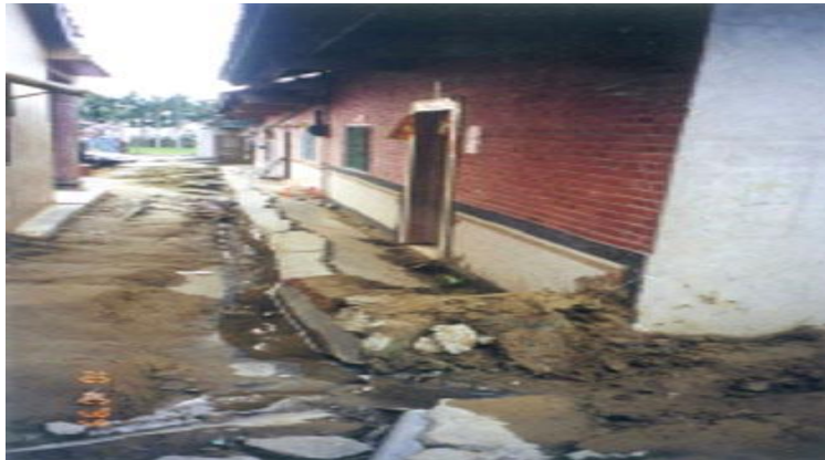
Figure 1. 12: Ebullition de sable dans un quartier résidentiel au Comté de Zhanghua (D'après r Hsein, 2002).
