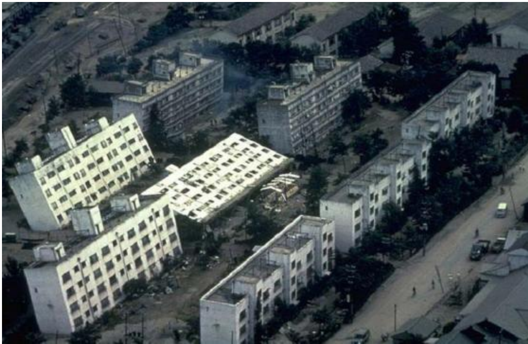
Figure 1. 3: Inclinaison des batiments d'appartements de Kawagishi-cho à Niigata au Japon dues à la chute de la capacité portante du sol par liquéfaction (Peter M. Byrne et al,2008)
