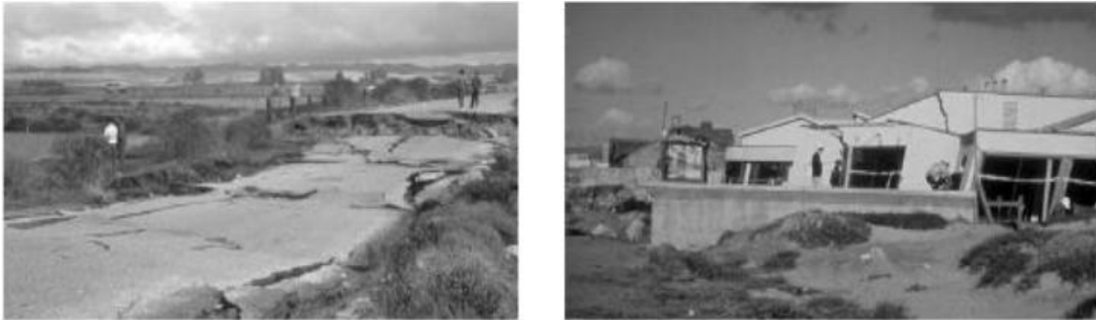
Figure 1. 6: Epandage latéral le long de la route Sandholdt (à gauche) et destruction d'un centre de recherche(à droite) à Moss Landing (D'après le Earthquake Engineering ResearchCenter,University of California , Berkeley; Elgamal et al,2001)
