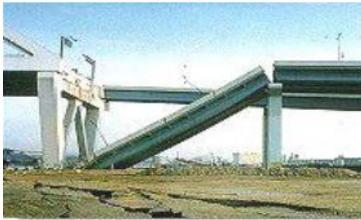
Figure 1. 9: Endommagement des ponts
