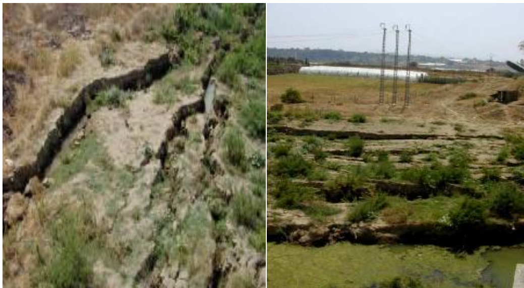
Figure 1. 22: Liquéfaction due à l'épandage latéral (D'après le EERI, 2003, cité par HaddadeneNacima 2008).
