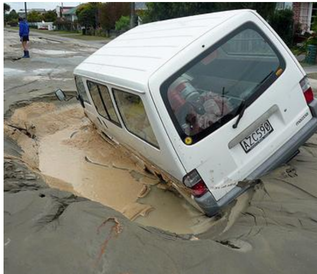
Figure 1. 18: Une camionnette qui malheureusement conduit dans un trou causé par la liquéfaction, du Nord de New Brighton, lors du séisme de Christchurch (2011).
