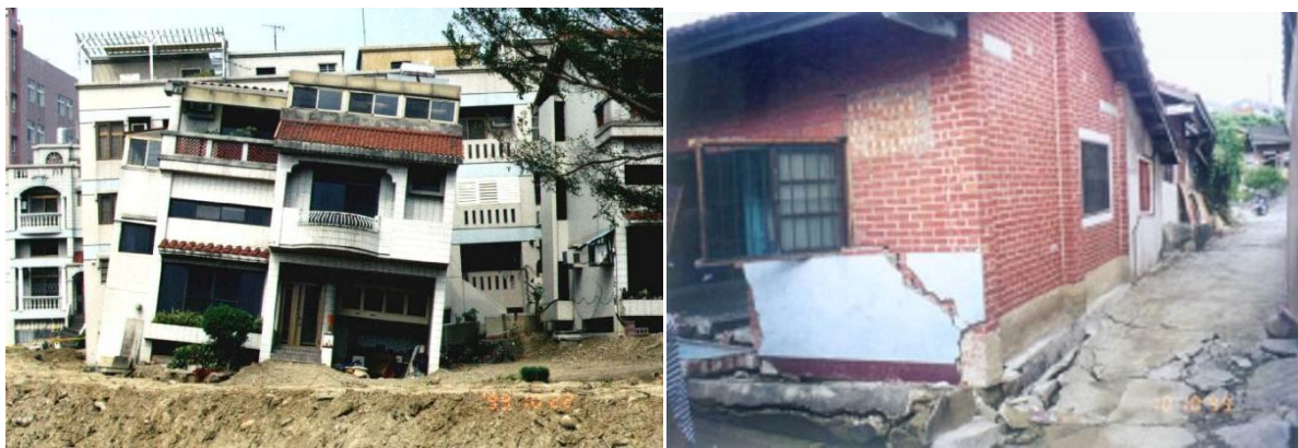
Figure 1. 14: Endommagement de bâtisses dû à la liquéfaction en Taiwan (D'après Dr Hsein,2002).
