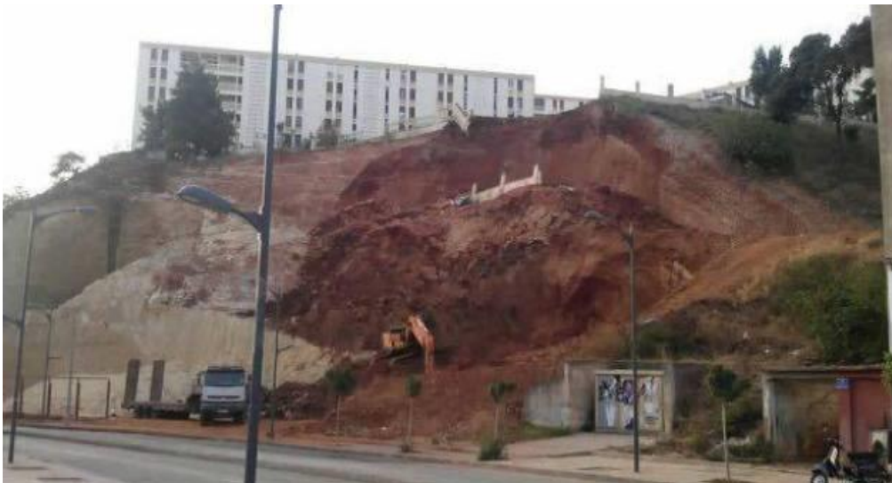
Figure 1.1 Glissement de terrain à Alger [El-Mouradia vers Bir Mourad Rais ,2019]
