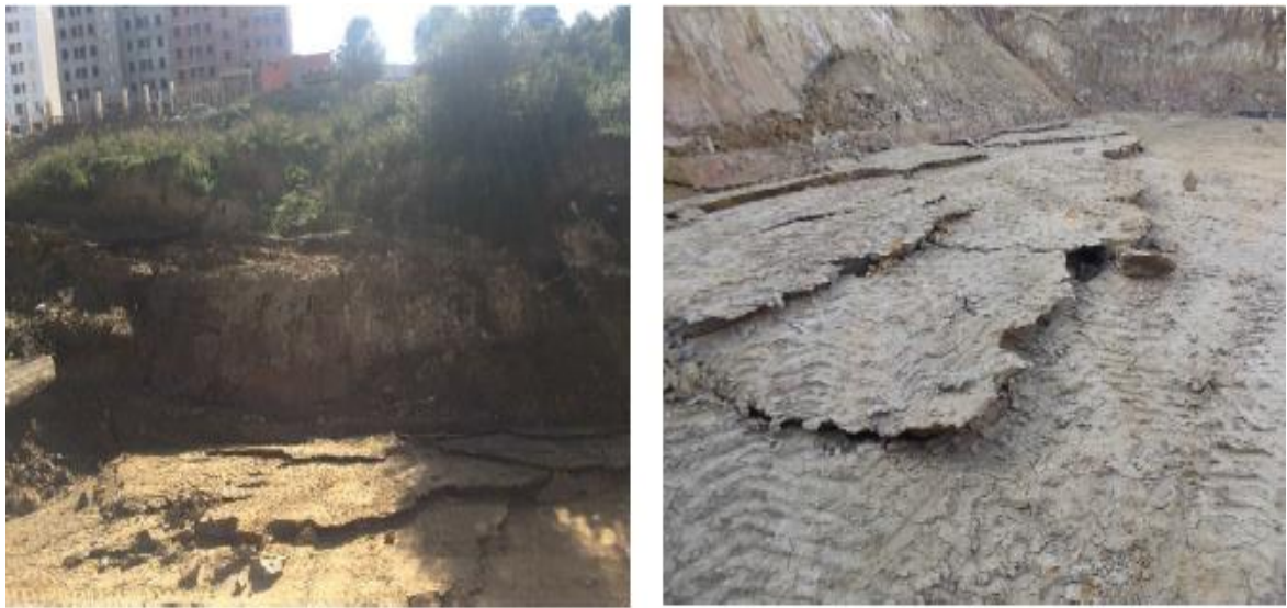
Figure 3.5 Photos montrant la morphologie du glissement (Rapport de sol)
