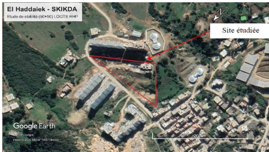
Figure 3.3 Localisation de site du glissement (Rapport de sol)
