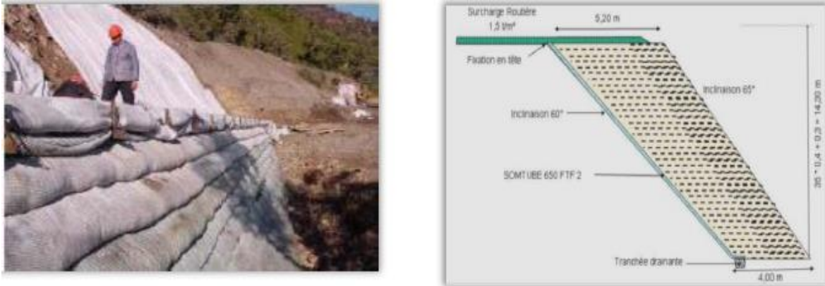
Figure 1.19 Chantier en cours de réalisation utilisant la technique géotextile
