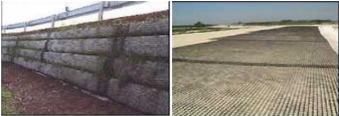
Figure 1.17 Renforcement par géo-synthétique.[8]
