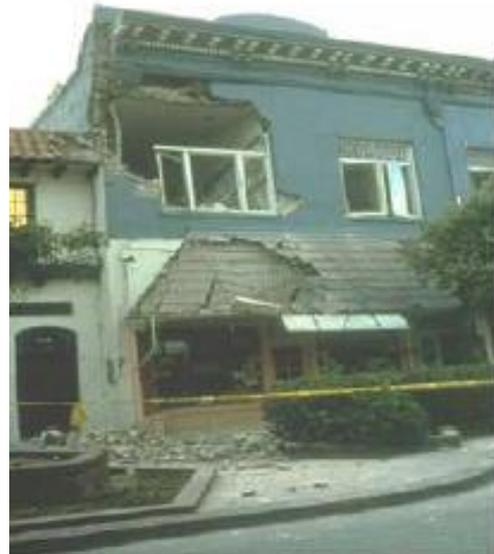
Figure 1.3. a) Effondrement d'un bâtiment [40], b) Effondrement d'un mur [44], (causé par le séisme de Loma Prieta 1989).
