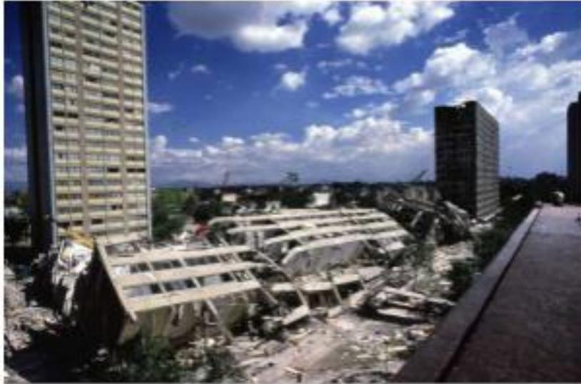
Figure 1.2. Destruction due au séisme de Mexico 1985.
