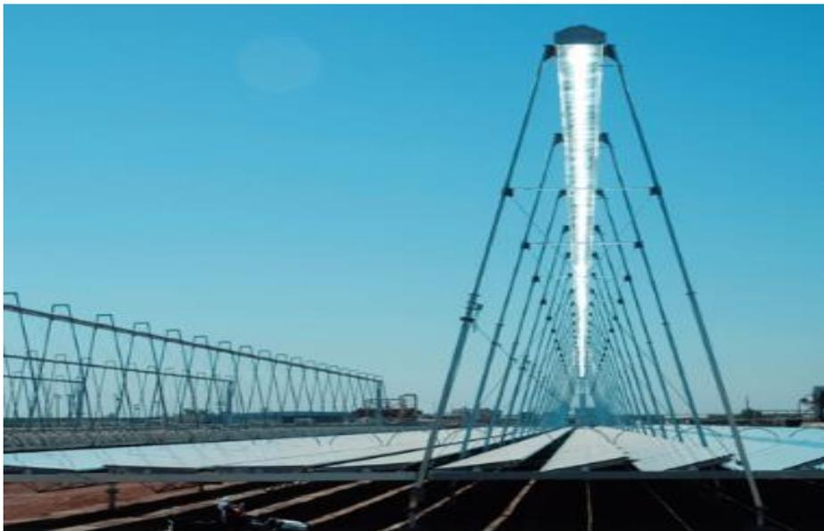
Figure II.4 Centrale solaire à miroir de Fresnel [3]
