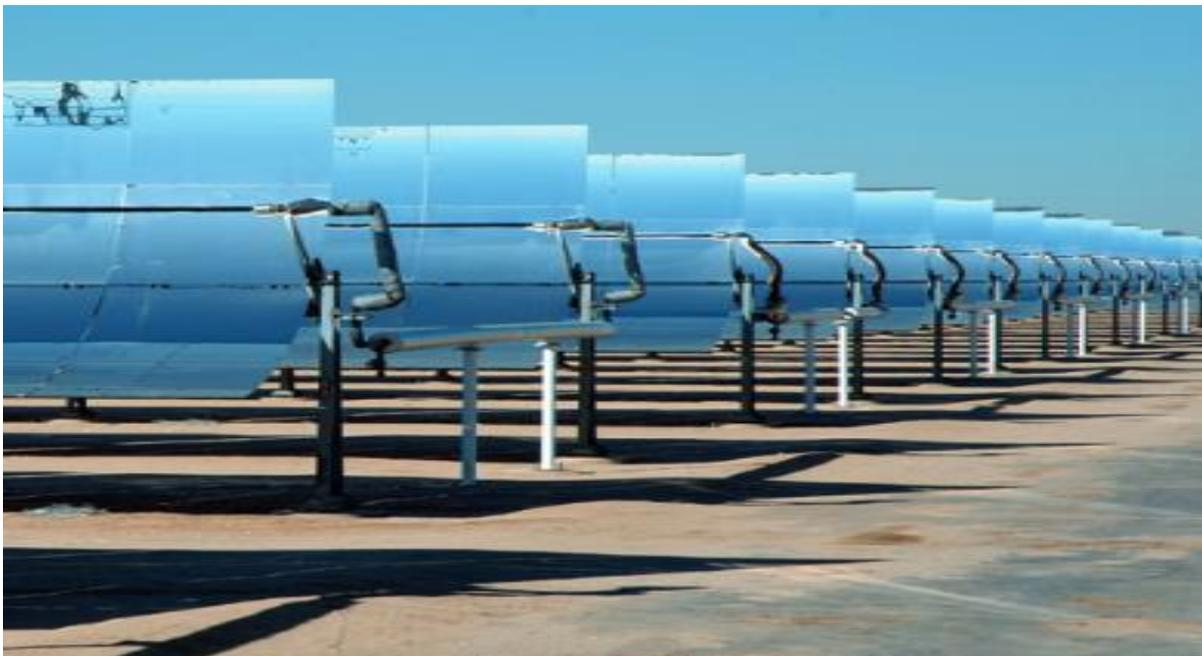
**Figure III.2** Concentrateur cylindro-parabolique [2]
