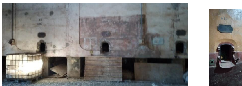
Figure 5: cuve de la cave de Chaabet El leham 44
