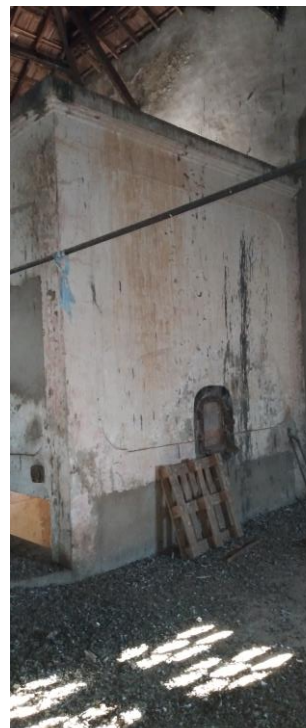
Cuve de refrigeration
