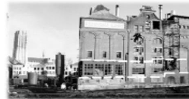
L'ancien bâtiment bâtiment
