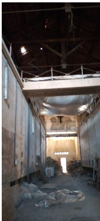
Cuves sur pilotis
