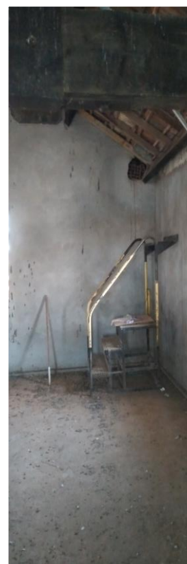
Echelle pour la cuve de refrigeration
