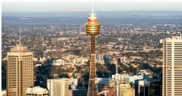
Figure II.11:2 AMTs de 220 tonnes dans un bâtiment de 305 m de hauteur (tour Sydney, Australie) (Allani 2015).
