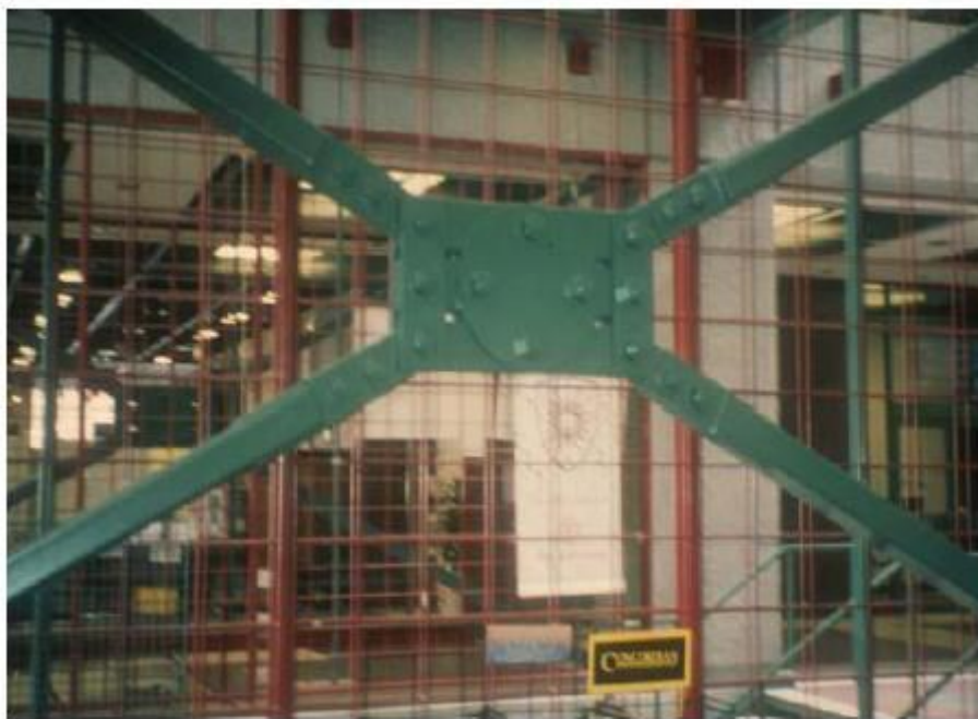
Figure II.3: Amortisseurs à frottement (Bentifour, 2013).
