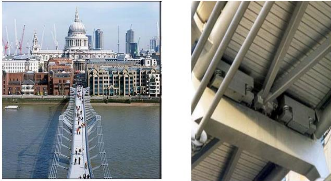
Figure II.10 : TMDs verticaux installés sous le tablier de la passerelle du Millenium à Londres (Allani 2015).
