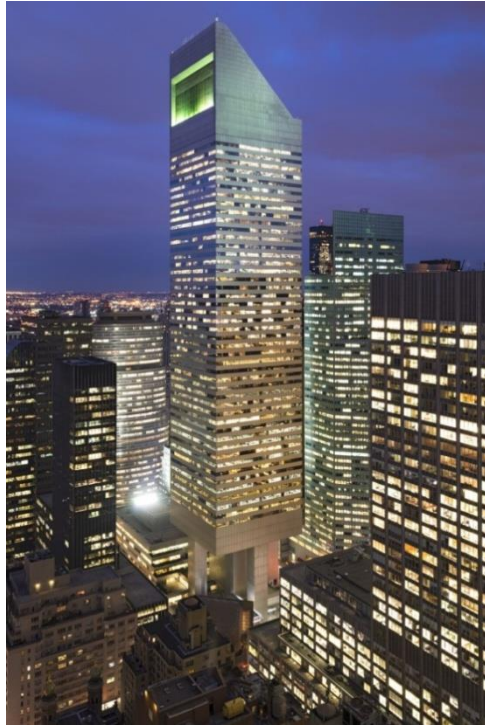
Figure II.12: Bâtiment « Citicorp Center »1977 [30].
