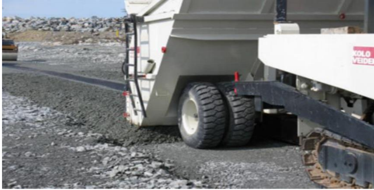
Figure III. 3: Mise en place du béton bitumineux [33].
