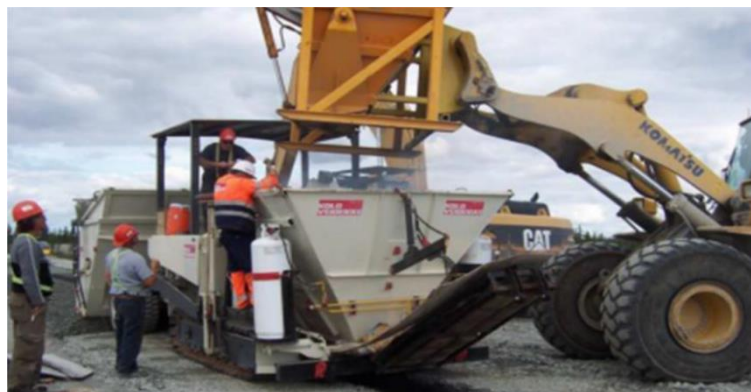
Figure III. 2: Chargement du béton bitumineux dans la paveuse [33].
