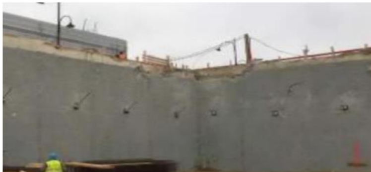
Figure III. 1: Paroi moulée en béton [32].
