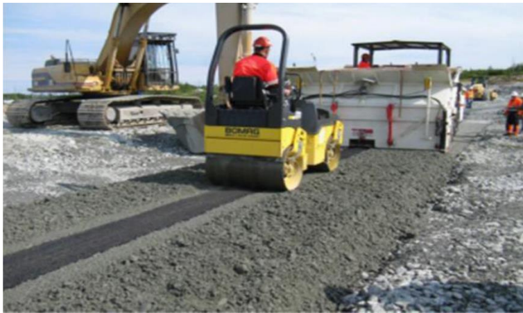
Figure III. 5: Opérations de compactage [35].
