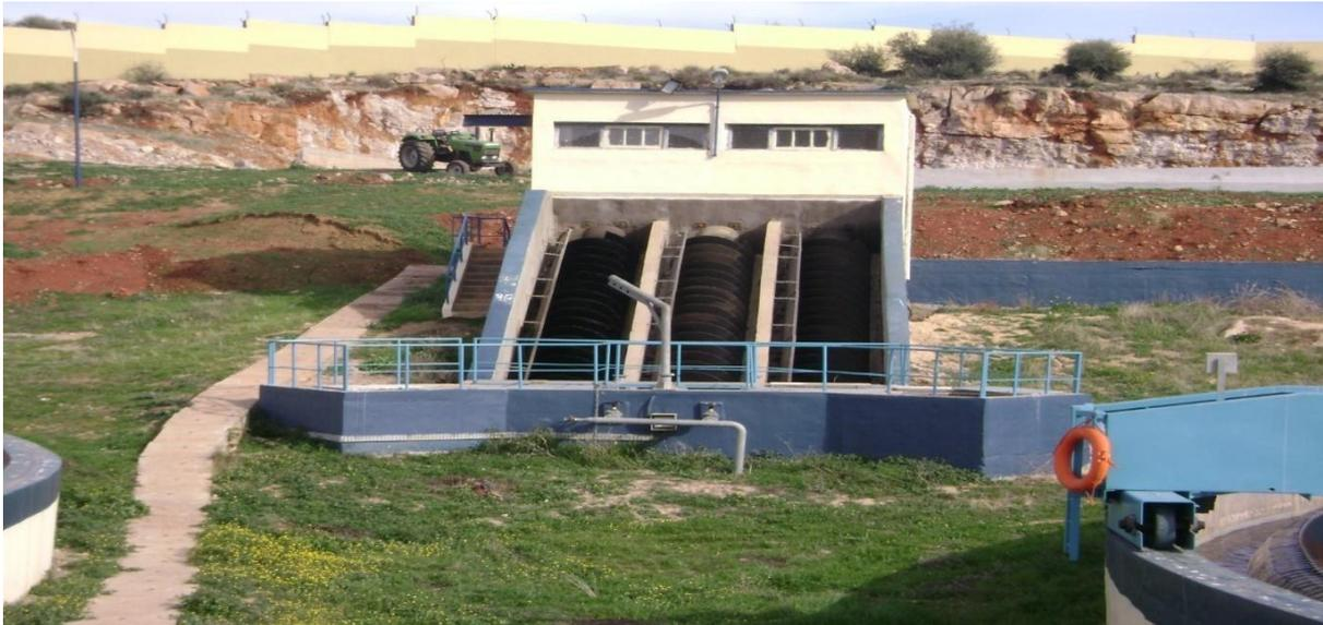
**Figure 11:** Vis de recirculation
