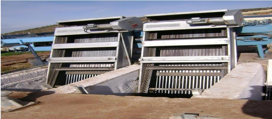
**Figure6:**Grille mécanisée (2 unités)
