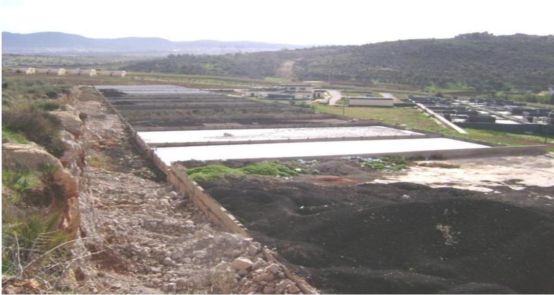
**Figure 13:**Lits de séchage +Aire de stockage
