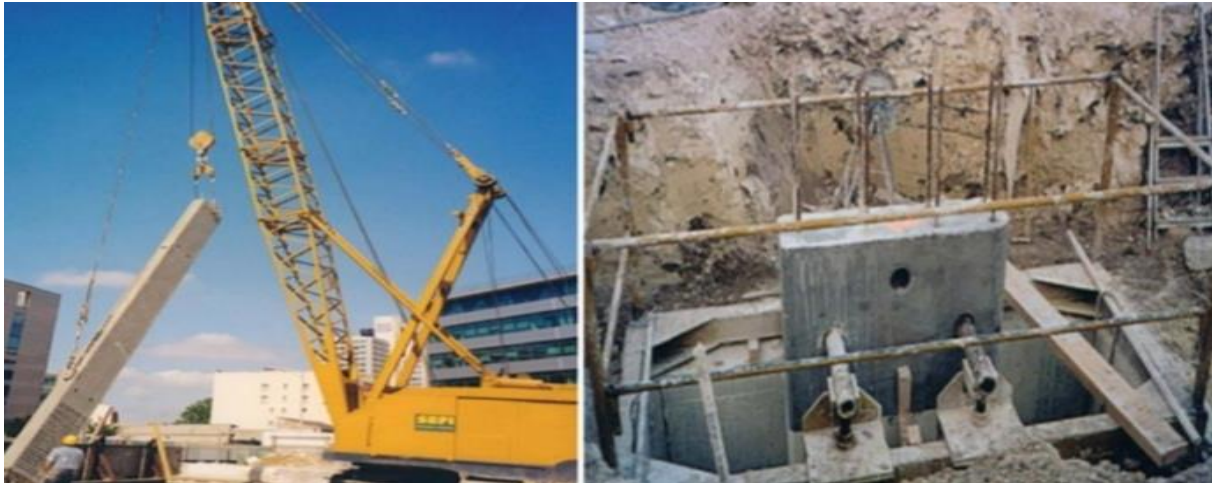
Figure I.18: Mises en place de barrette.
