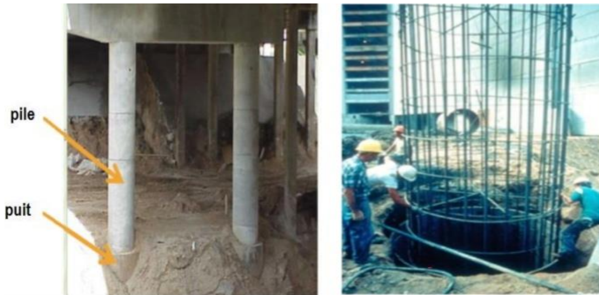
Figure 1.11: Exemple de réalisation des fondations semi-profondes.
