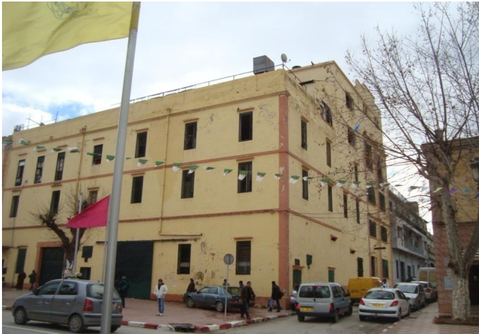
Figure II.4.a : les deux façades de l'immeuble
