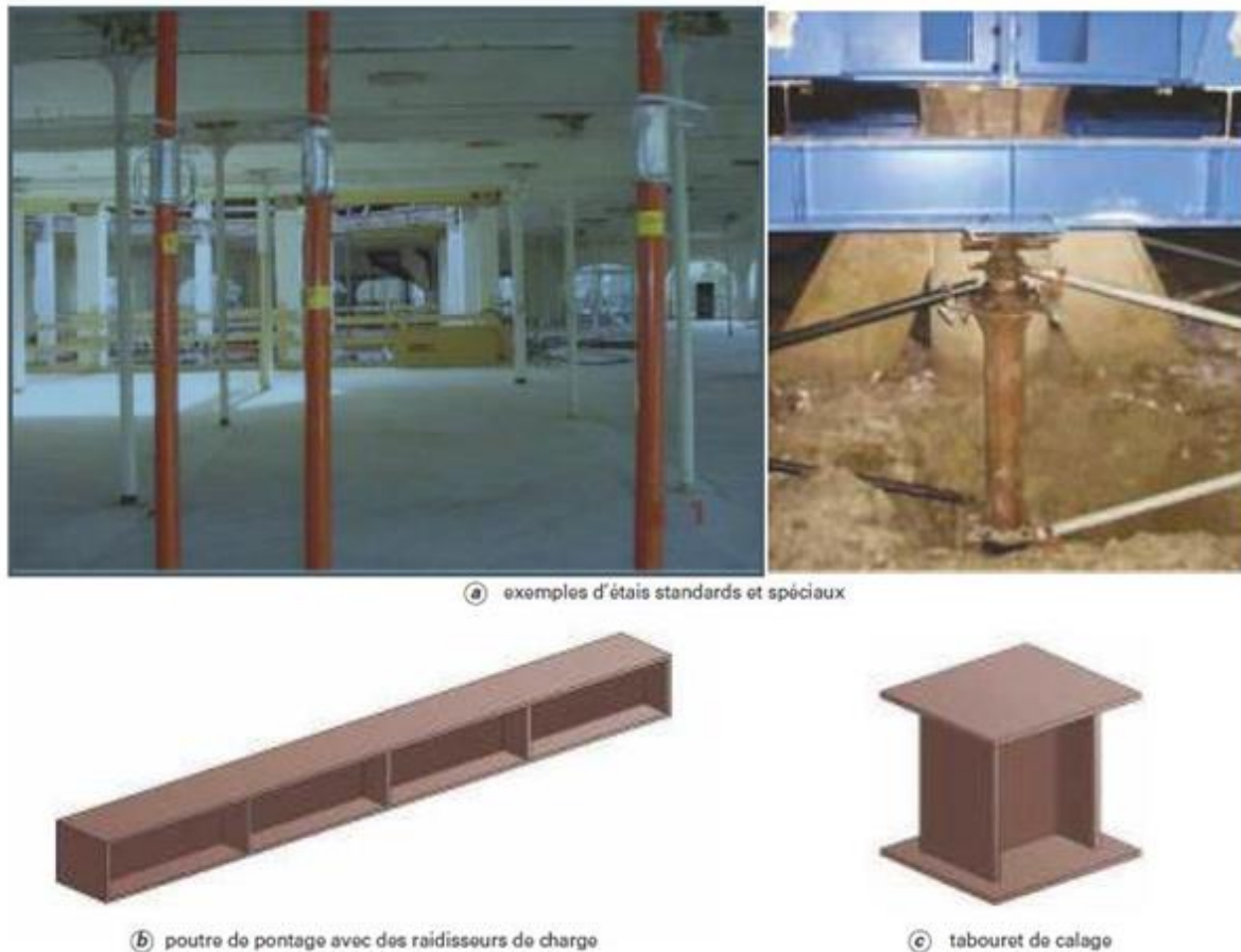
Figure I.7 quelques type d'étais et de calles [3]
