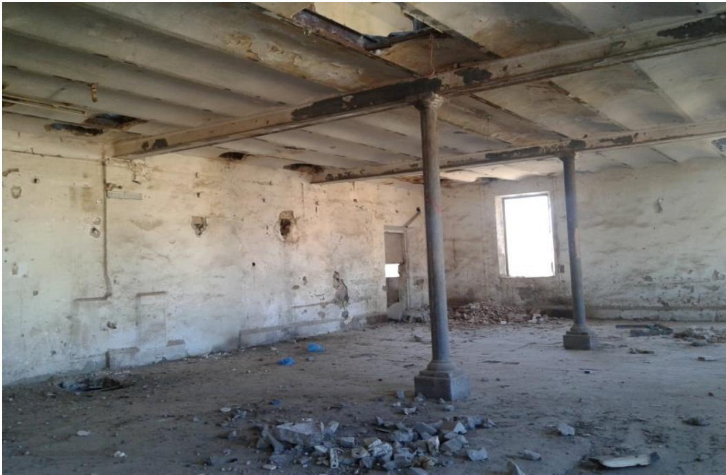
Figure II.13 : Etat de lieu des étages
