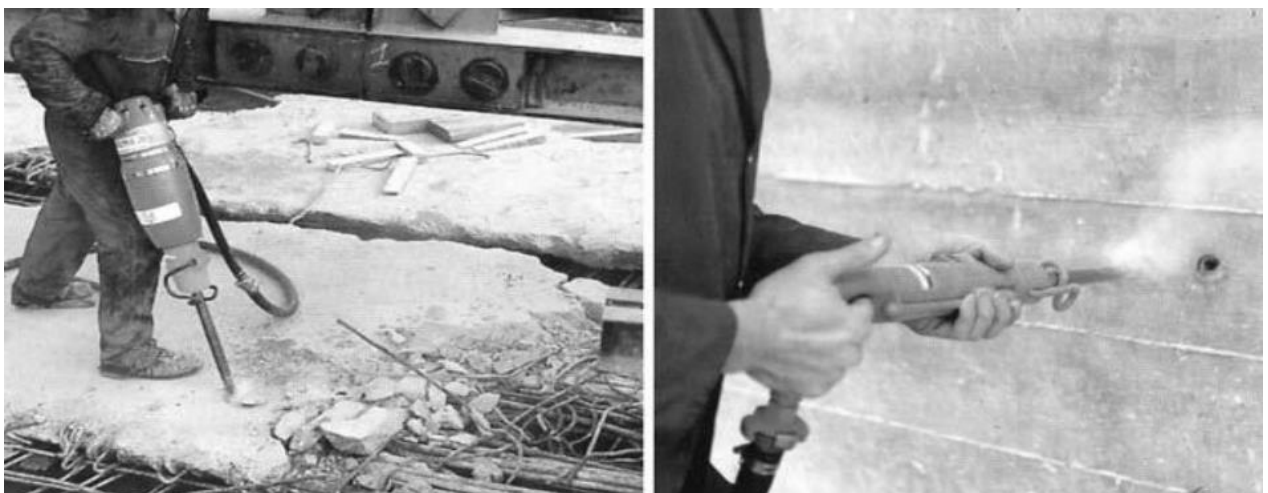
Figure VI.3 : matériels légers utilisés pour la démolition
