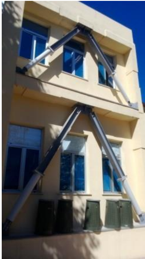
Figure I.4 : Contreventement dissipatif dans les cadres de façade en béton armé une fois les travaux terminés.
