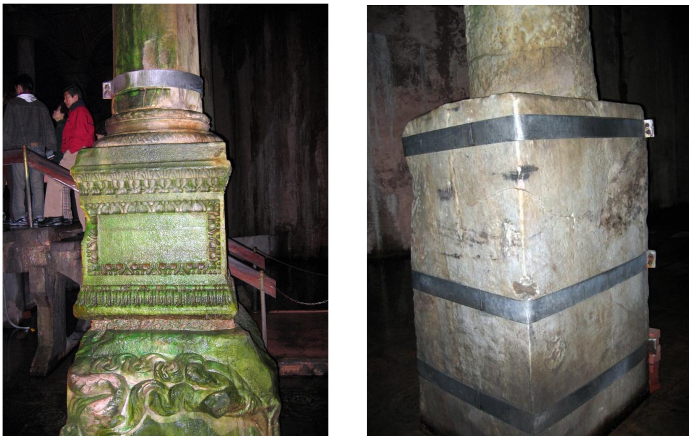
Figure I.23 : exemple de renforcement avec des cerclages
