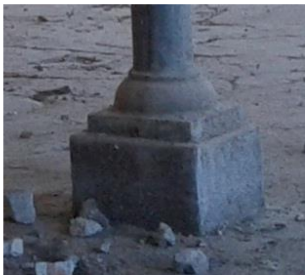
Figure II.11 : poteau reposant sur pierre de taille
