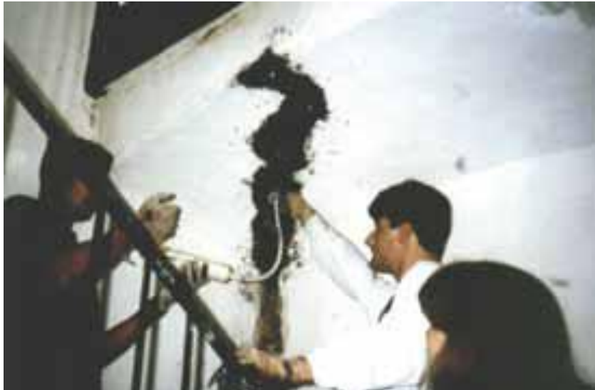
Figure VI.6 : colmatage des fissures par injection
