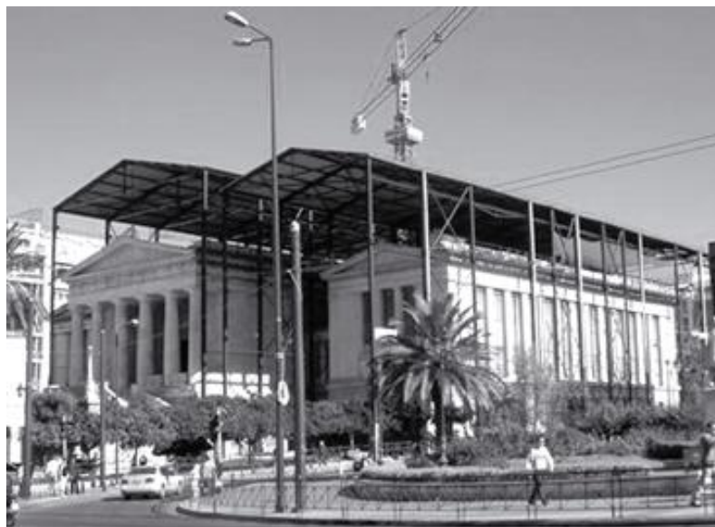
Figure I.1 Toit provisoire protégeant le site pendant les travaux de restauration (Athènes, Grèce)
