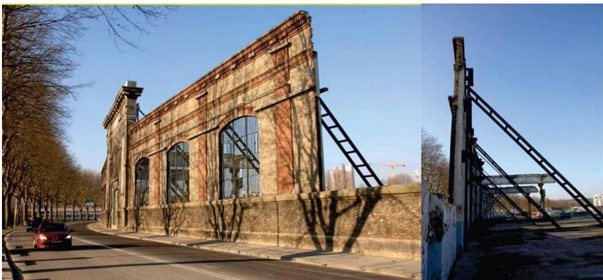
Figure I.30 : étaieage interne d'une façade historique des usines Renault à Boulogne Billancourt – France
