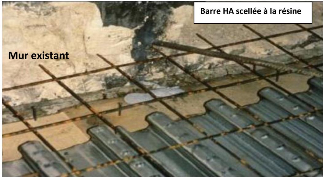
Figure VI.16: exemple des cas d'accrochage sur un mur existants
