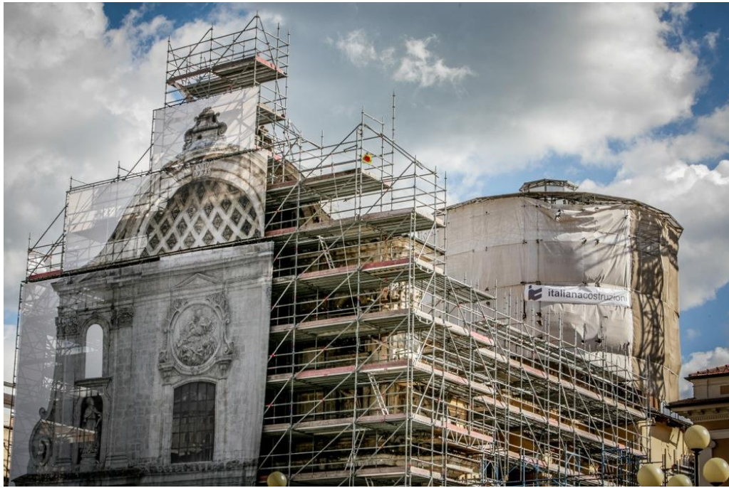
Figure I.5.a : Restructuration de l'église santa maria(vue extérieur)
