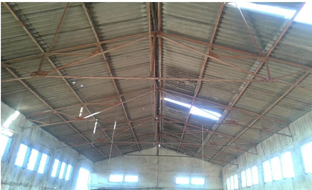
Figure II.14 : Couverture de la toiture du dernier étage.
