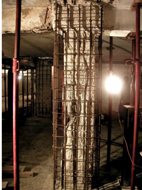
Figure I.3 : chemisage d'un poteau
