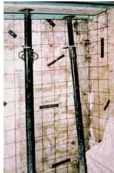
Figure VI.9 : renforcement du mur par des armatures
