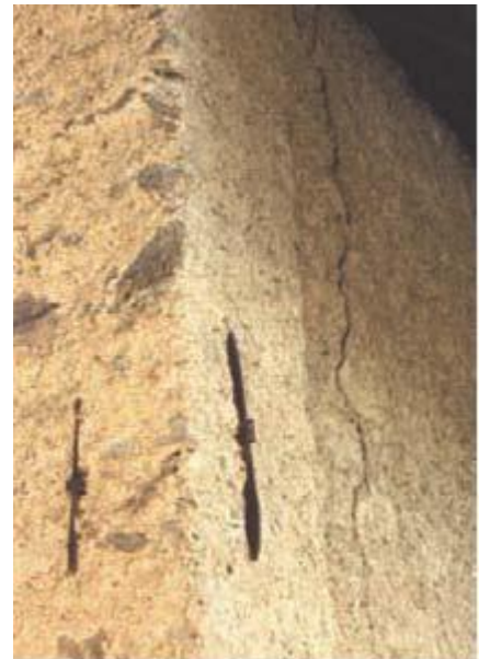
Figure VI.11 : Boulons d'ancrages pour clouage
