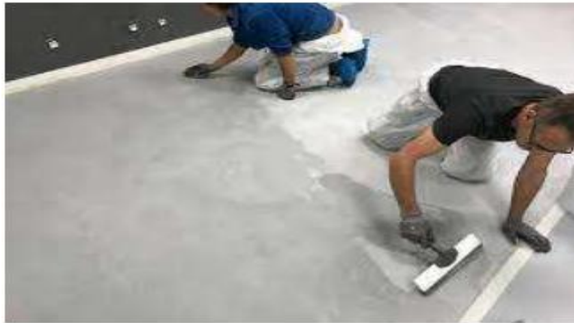
Figure 1.11: Application de lasure sur toiture en béton (Aurenti, 2016)
