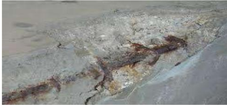
Figure 1.4: Carbonatation du béton (Carbonatation_du_béton, consulté le : 25 Mai 2022)
