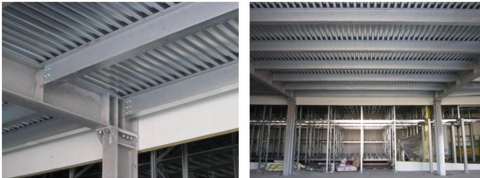
Figure 81 : Plancher en tôle pliée qui repose sur des poutres et poteaux métalliques <sup>130</sup>
