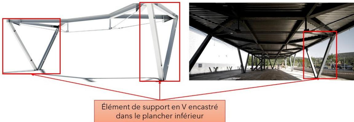
**Figure 85 : Élément métallique en V de support de la toiture tridimensionnelle <sup>134</sup>**
