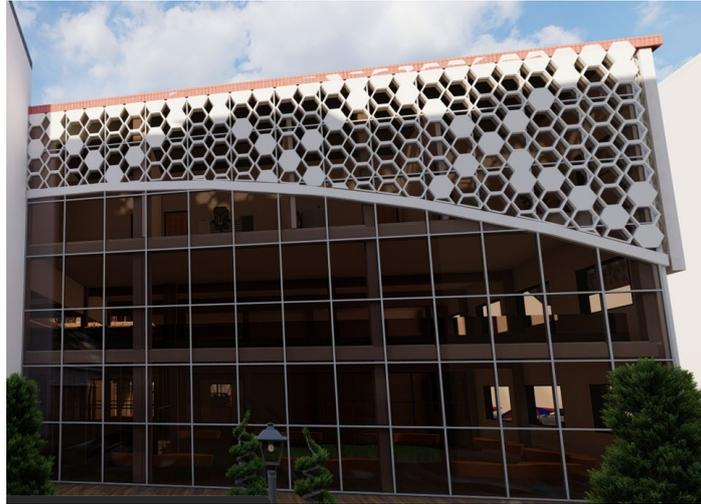
**Figure 65 : Elément en moucharabieh pour le traitement des façades <sup>109</sup>**
