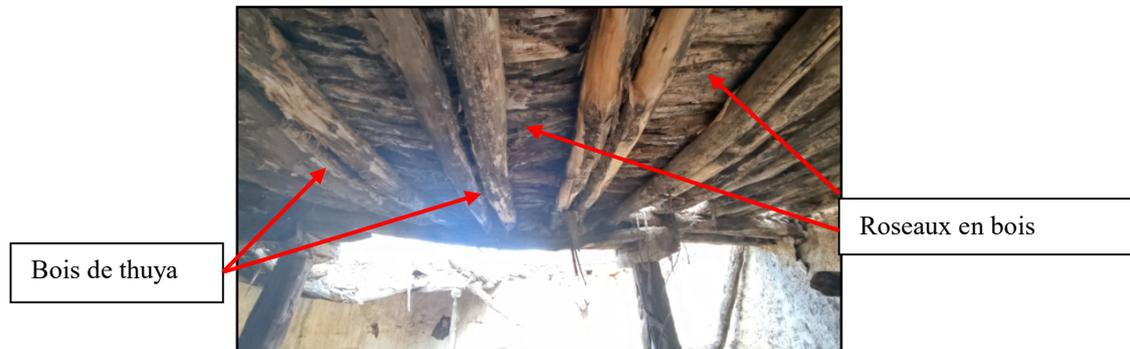
*Fig86 –plancher d'une maison traditionnelle<sup>143</sup>*
