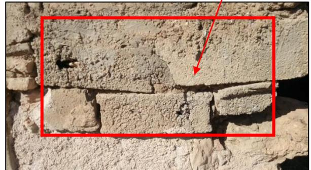
Figure 73: parpaing de ciment sur la façade sud
