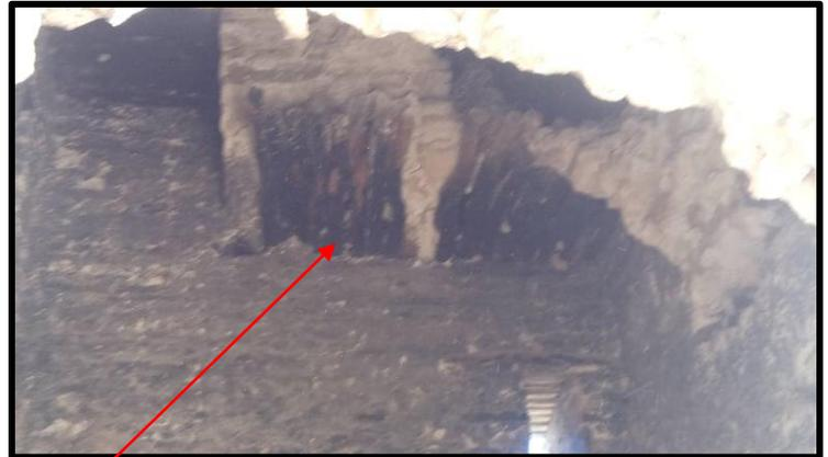
Figure 75: partie d'escalier détruite à l'intérieur du minaret
