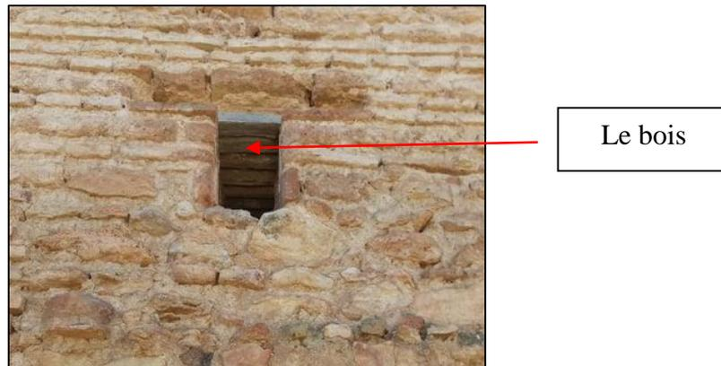
**Figure 66: les linteaux des ouvertures en bois**
