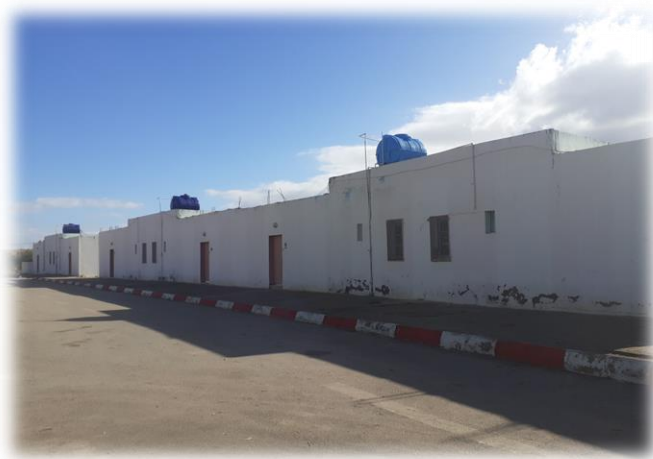
Figure 35 : l'actuelle station thermale (les bungalows)
