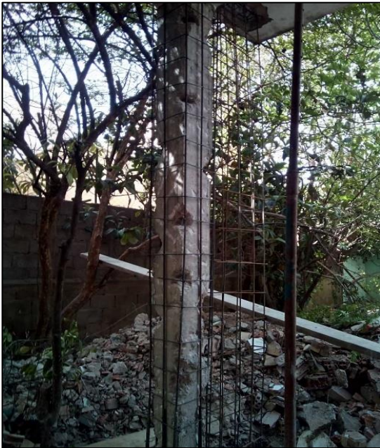
Figure 4 : la technique de chemisage / source : prise par l'auteur
