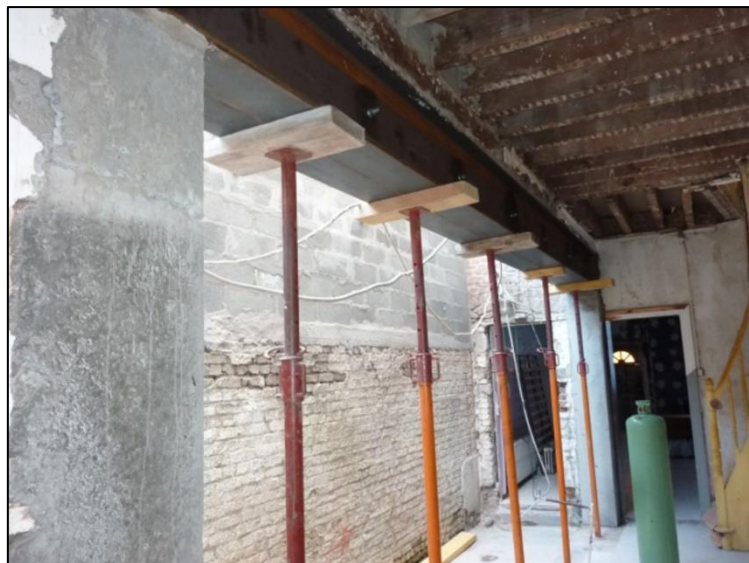
Figure 1 : la technique de l'étaielement / source : google images
