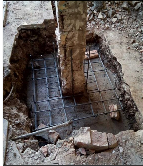
Figure 3 : la technique de chemisage / source : prise par l'auteur
