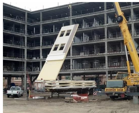
Figure 30: installation d'un panneau de revêtement de façade source : https://wpibuilds.com
