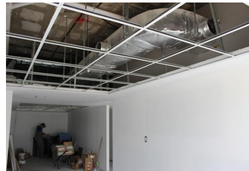
Figure 131: faux plafond partiellement posé (source : google)
