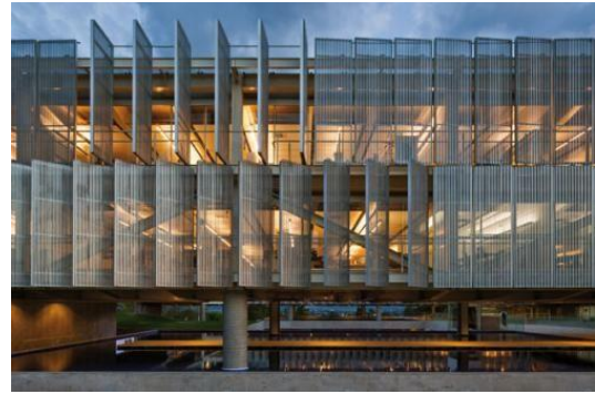
Figure 138: façade d'un siège à Brasilia (source : filt3rs.com)
