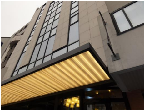
Figure 99: un auvent d'un bâtiment
