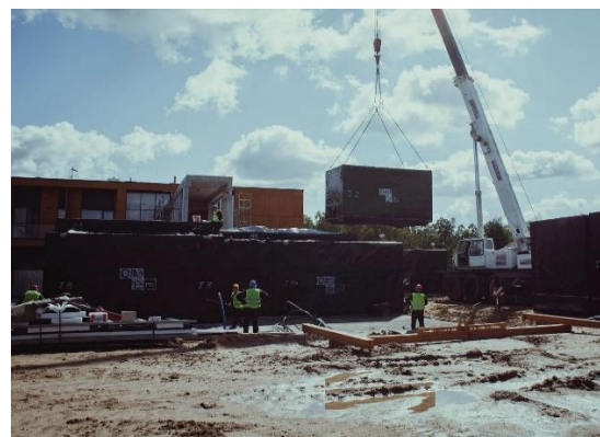
Figure 63: installation des modules de chambre (source DMD modular)
