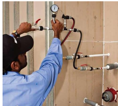
Figure 19: installation des tuyauteries dans les modules
