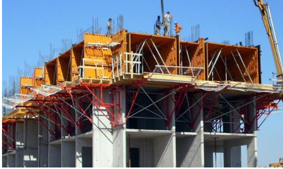
Figure 39: construction avec le coffrage tunnel (source : google image)
