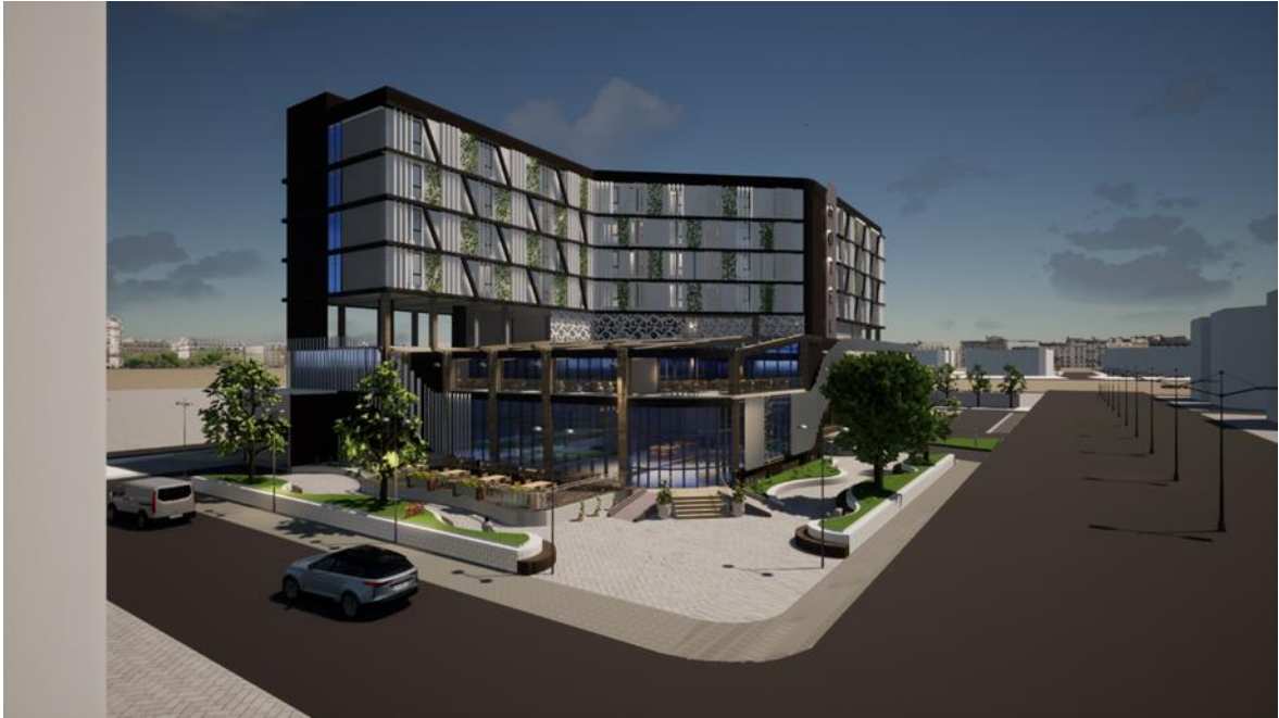
Figure 145: vue de l'hôtel de voie principale
