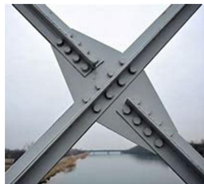
Figure 25: assemblage par boulonnage
