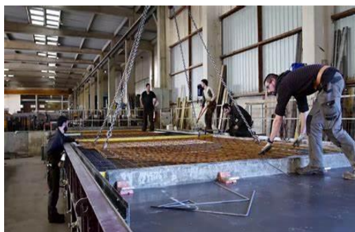
Figure 6: usine de préfabrication du béton
