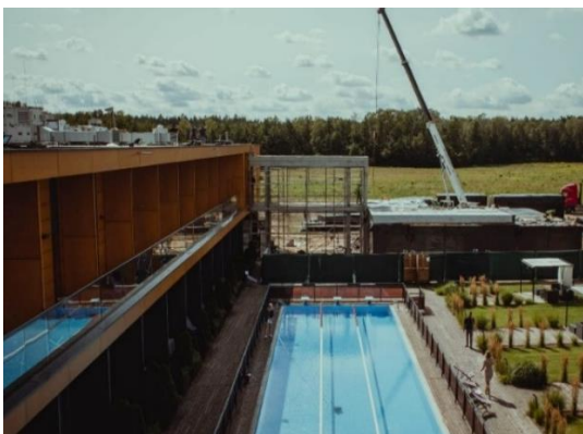
Figure 62: travaux de construction de l'extension (source: DMD modular)
