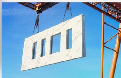
**Figure 5:** panneau de façade en béton préfabriqué
