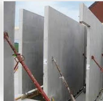
**Figure 9:** Murs en béton préfabriquée
