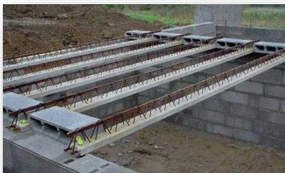
**Figure 4:** Poutrelle en béton armé préfabriqué
