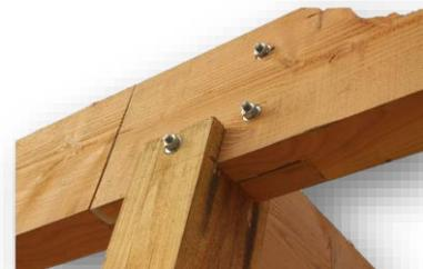
**Figure 30:** Assemblage poutre primaire sur poteau en bois
