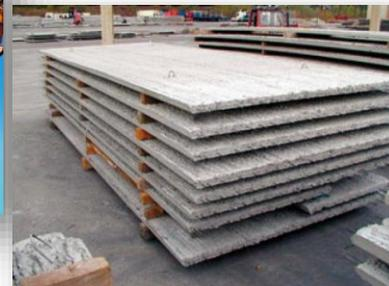
**Figure 6:** Les planchers à prédalles préfabriquées
