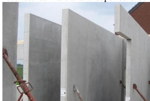
**Figure 19:**panneau en béton plein
