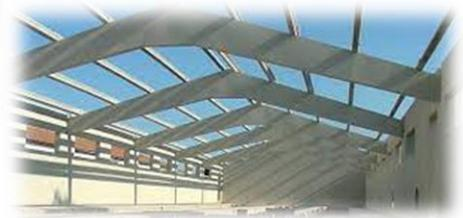
**Figure 14:** Portique en béton
