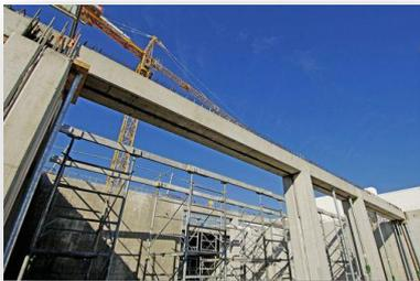
**Figure 7:** Poutre préfabriquée
