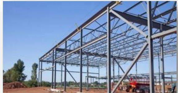
**Figure 10** Construction industrialisée à portique métallique.
