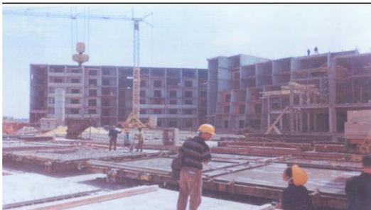
Figure 9 : Atelier précaire à l'air libre au pied de l'ouvrage à édifier.
