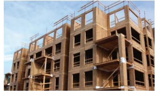
Figure 17 : Bâtiment de 5 étages à ossature légère en bois en construction en Colombie-Britannique.
