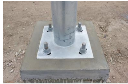
Figure 99: Fondation en semelle isolée Source: google image
