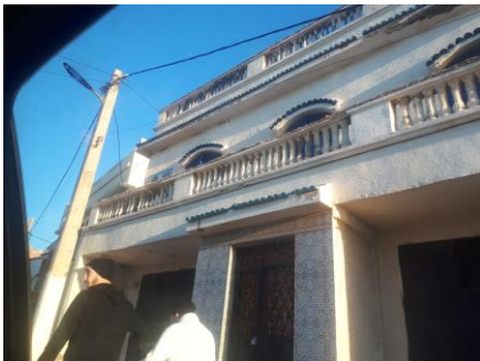
Figure 64: photo de l'état de bâtis Source: Auteur
