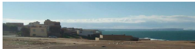
Figure 75: Limite ouest du terrain Source: auteur
