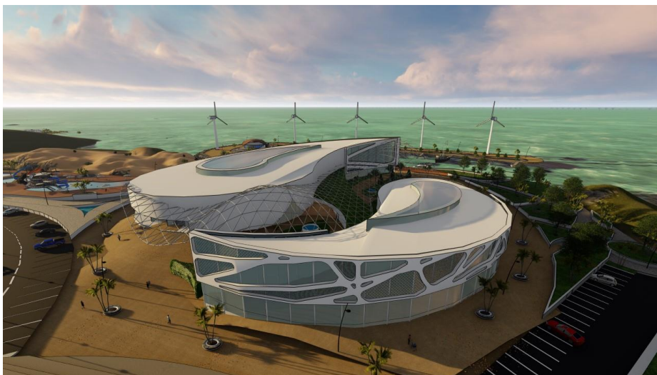
Vue d'ensemble sur le projet
