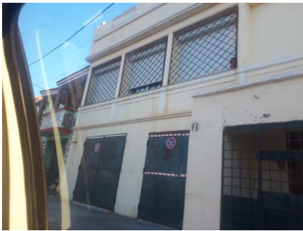
Figure62: photo de l'état de bâtis Source: Auteur
