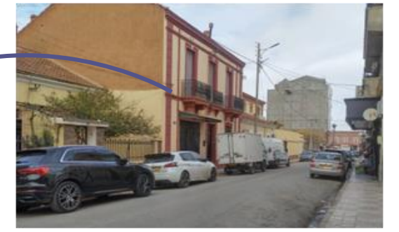
Maison Coloniale en R+01
