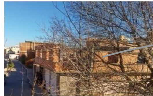
Habitations en cours
