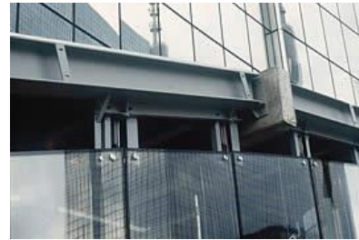
Figure 65. mur-rideau monté en panneau et mur-rideau en verre structural. 117
