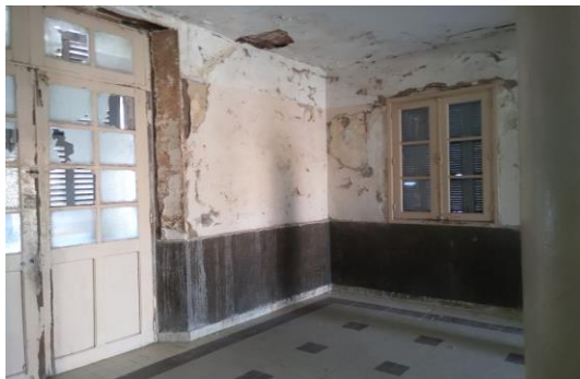
L'intérieur du bâtiment de la gare
