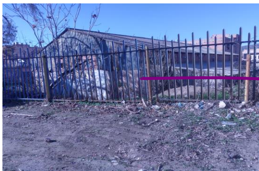
Dépôt de la gare
