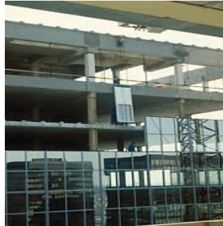
Figure 65. mur-rideau monté en panneau et mur-rideau en verre structural. 117
