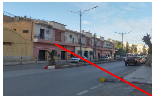
Maison Individuelle R+01 avec services au RDC Elle date de la période coloniale
