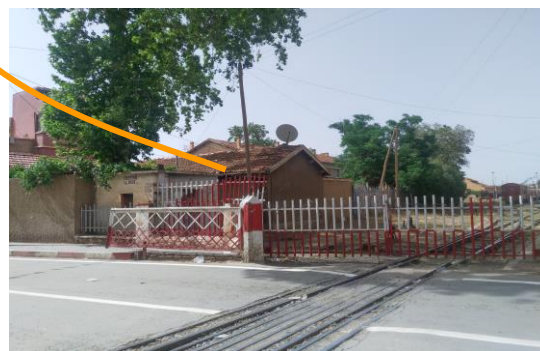
Logements de fonction de la gare
