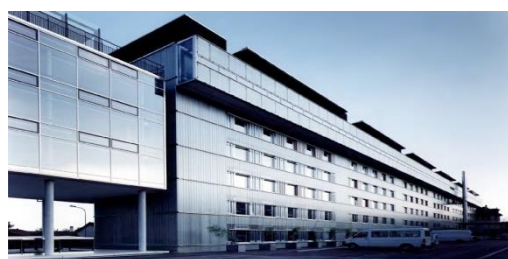
Figure 10. Le bâtiment principal de l'OFS 27 .
