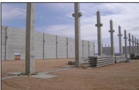
**Figure 12:** Poteaux en béton préfabriqué
