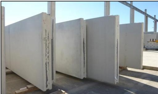
**Figure26 :** Panneaux en béton armé
