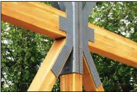
**Figure24 :** Assemblages de système préfabriqué en bois
