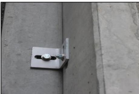
**Figure29** : Assemblage des dalles
