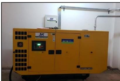
**Figure 185:** Groupe électrogène (Source : skgenerateurs.dz)
