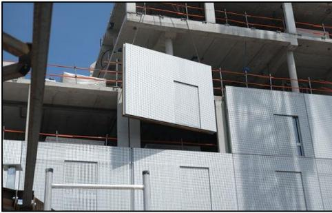
**Figure 07:** Panneaux de façade préfabriqués
