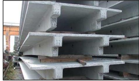
**Figure 164:** Plancher double nervuré (Source : Precast\_Concrete\_Frames\_Guide.pdf)
