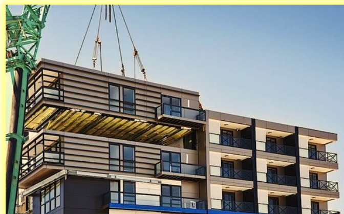
Figure 2 Installation d'un module complet. (hors-site s.d.)
