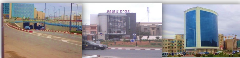
Figure 51 rond-point centre de conventions. (Auteur)
