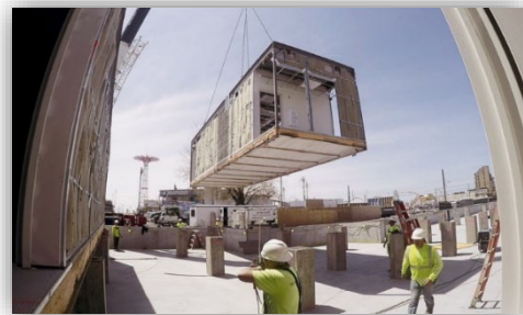
Figure 5 Assemblage des modules 3D. (martin-calais 2019)
