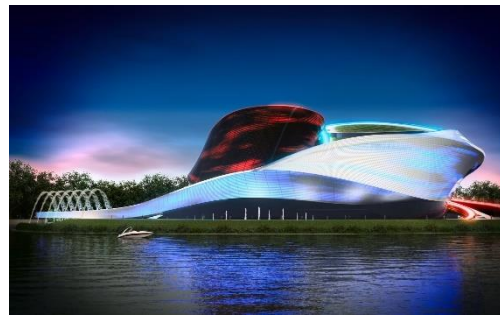
Figure 101 façade de l'opera
