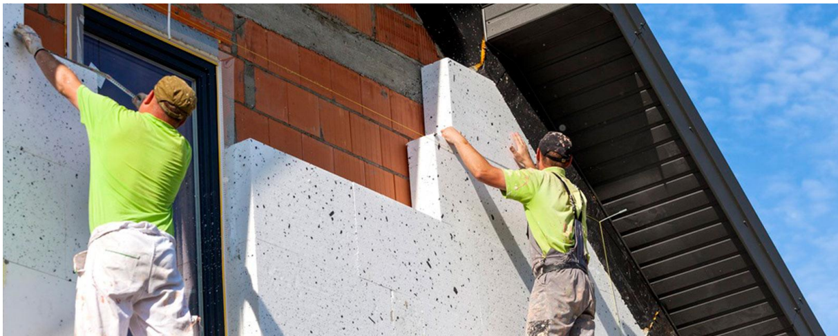
Figure I-6 Exemple sur l'isolation par extérieur.
