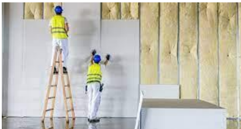
Figure I- 4 exemple isolation par intérieur
