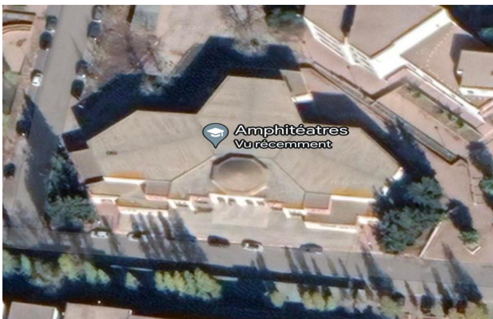
Figure II-1 Vue aérienne du bloc des grands amphis [Google Earth Pro]
