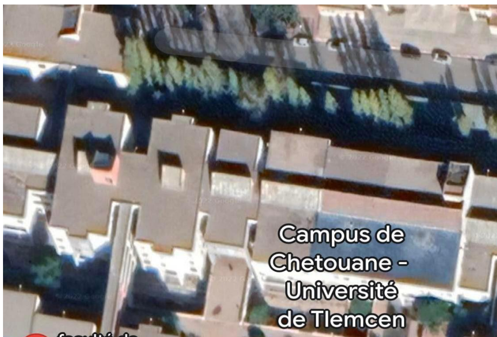
Figure II-3 Vue aérienne du bloc pédagogique [Google Earth Pro]
