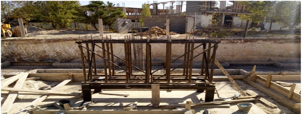
**Figure 2. 13:** Massif de réaction en pendant la réalisation.
