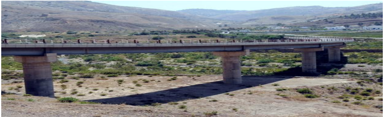
Figure.I.2. Pont à La Wilaya de Mostaganem(SAPTA2008°
