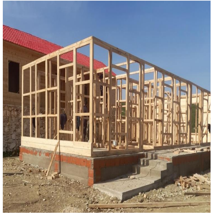
(f) Construction d'un chalet (50%)
