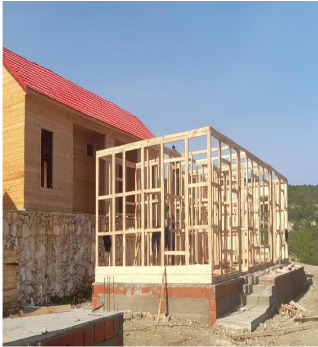
(e) Construction d'un chalet (45%)
