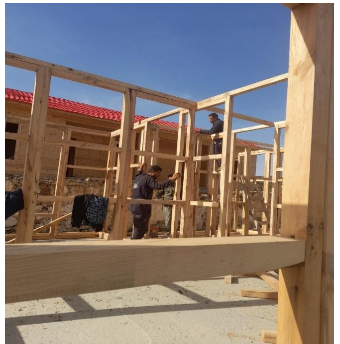
(d) Construction d'un chalet (30%)
