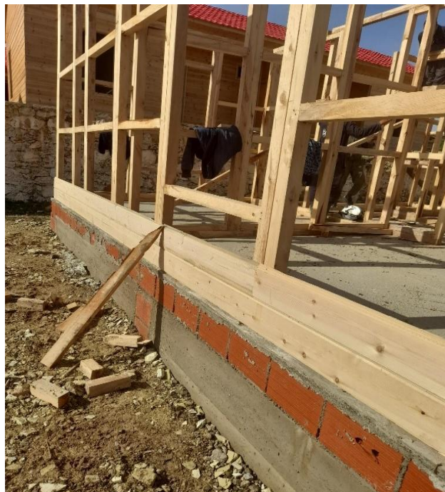
(c) Construction d'un chalet (20%)
