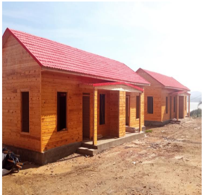
(h) Construction du chalet terminée (100%)
