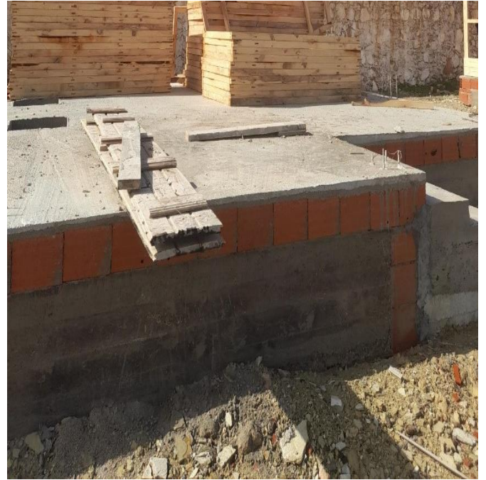
(b) Début de la construction de superstructure
