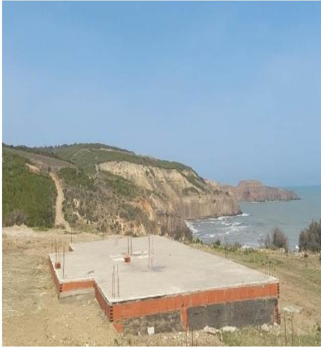
(a) plateforme en béton pour la construction d'un chalet
