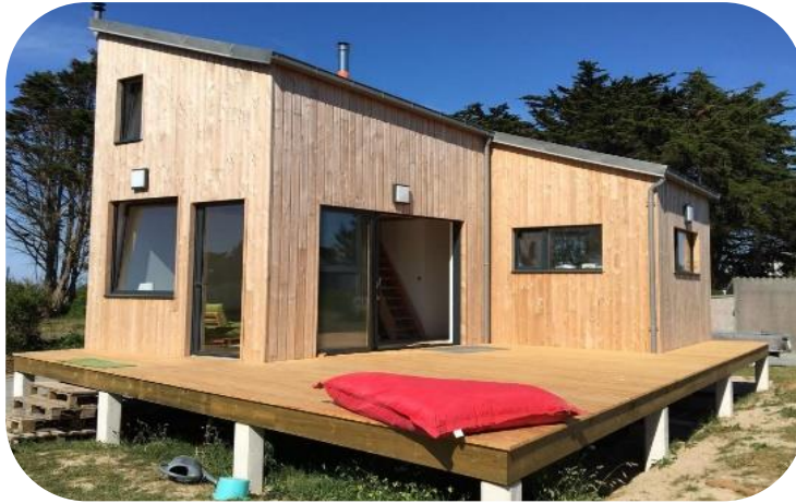
Figure I.5. Maison ossature bois l'Acacia [19]
