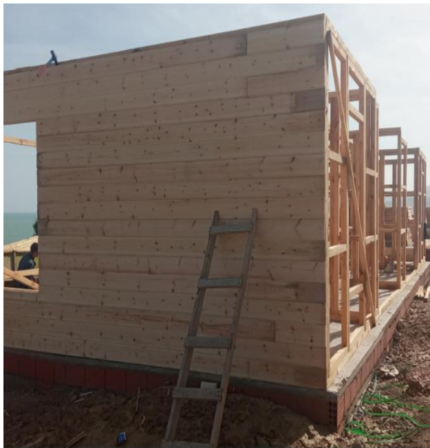
(g) Construction d'un chalet (65%)
