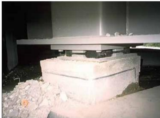
Figure II.12 : Exemple d'un appareil d'appui (photo).
