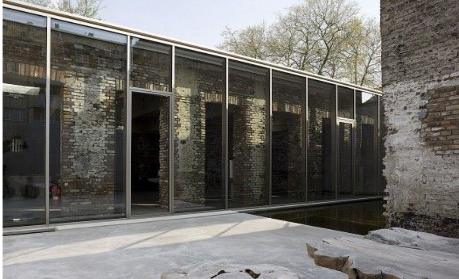
Figure 2-1: Installation du mur trombe avec brique et architecture écologique [33]
