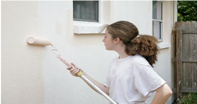
Figure 2-30: peinture isolants extérieur 33
