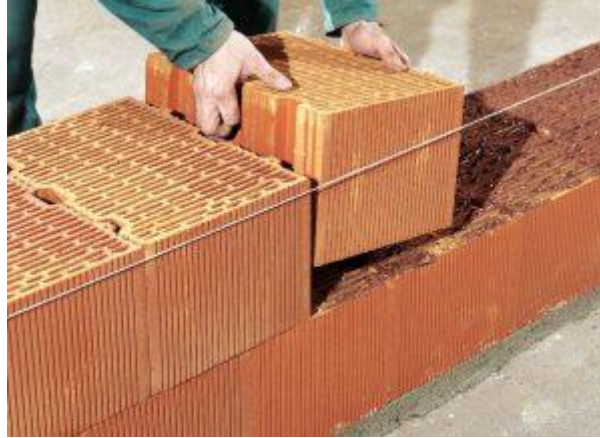
Figure 2-36: les blocs mono murs en terre cuite 39
