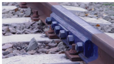
FIGURE 2.24 – Utilisation de boulon d'éclisse[1].
