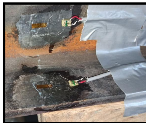
(b) Jauges connectées à des câbles électriques
