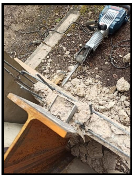
(a) Démolition de la dalle
