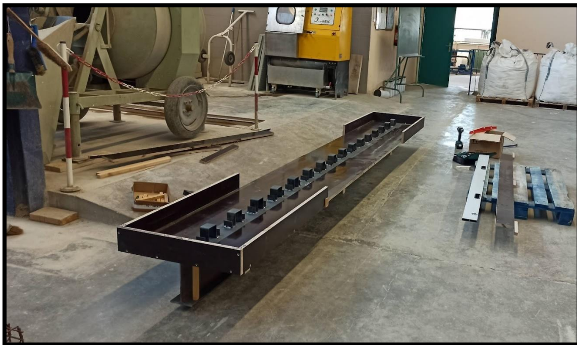
(b) Fabrication du coffrage en bois du spécimen de poutre mixte.
