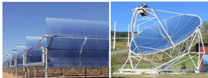
Figure 8: Types de capteur pour concentration thermodynamique.
