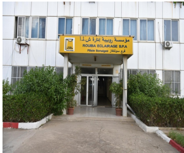
Figure 19: L'usine de Rouïba Eclairage.
