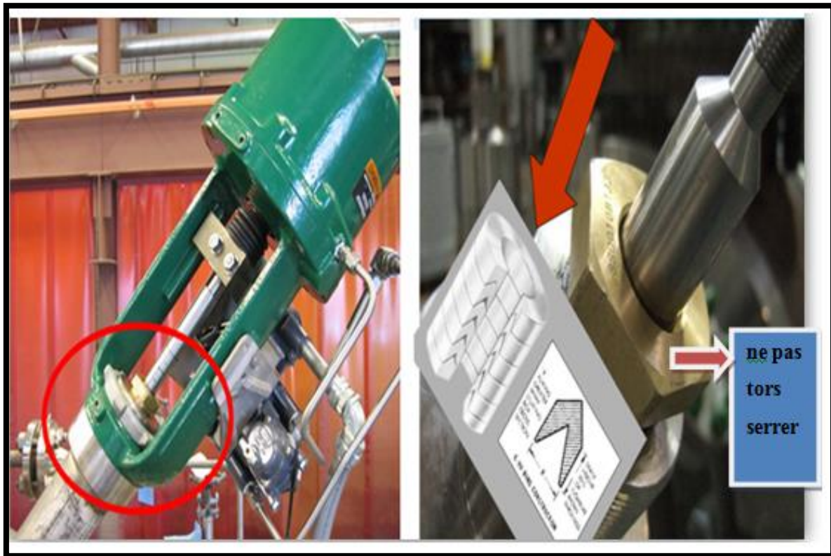
Figure IV. 9: Photo réel de l'actionneur des aubes directrices d'entrée et l'étanchéité en téflon
