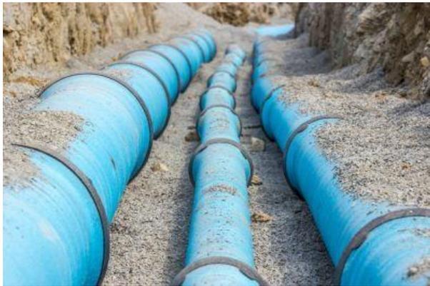
*Figure 4. 1 : Canalisation enterrée*
