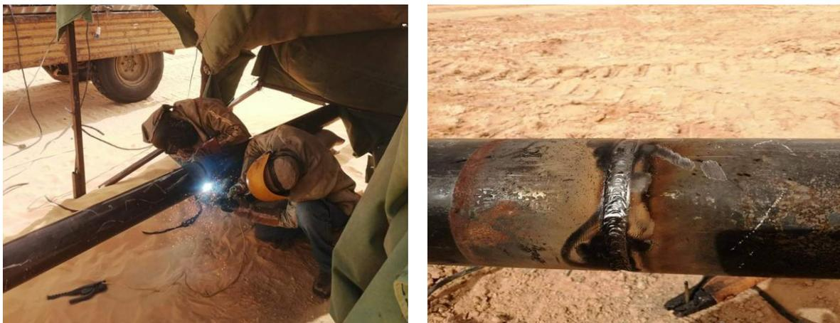
*Figure 5. 6 : le soudage SMAW pendant et après l'opération de soudage*
