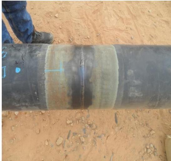
Figure II.17 : Cordon de soudure
