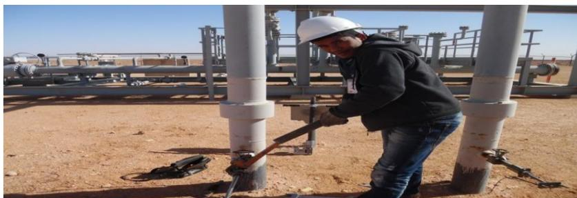
Figure IV.8 : L'emplacement du coupon
