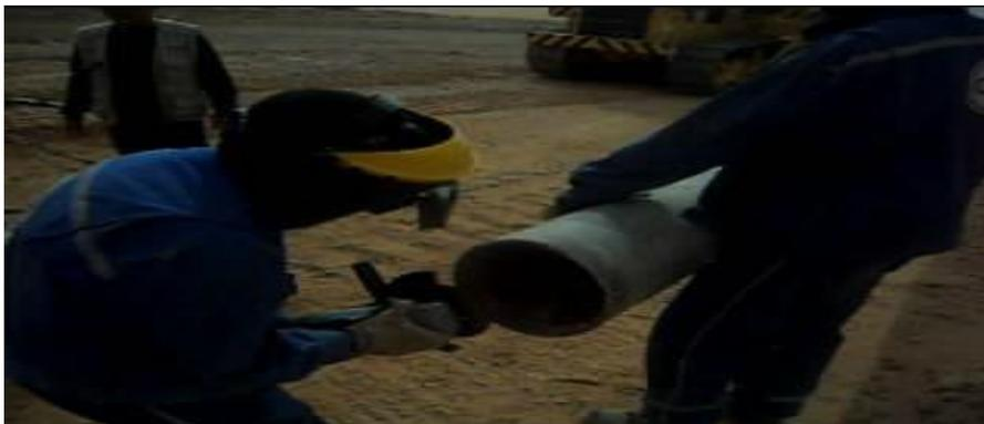
Figure II.11 : Chanfreinage du gazoduc
