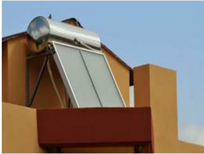
Figure 2.17 Chauffe eau solaire à thermosiphon. [61]
