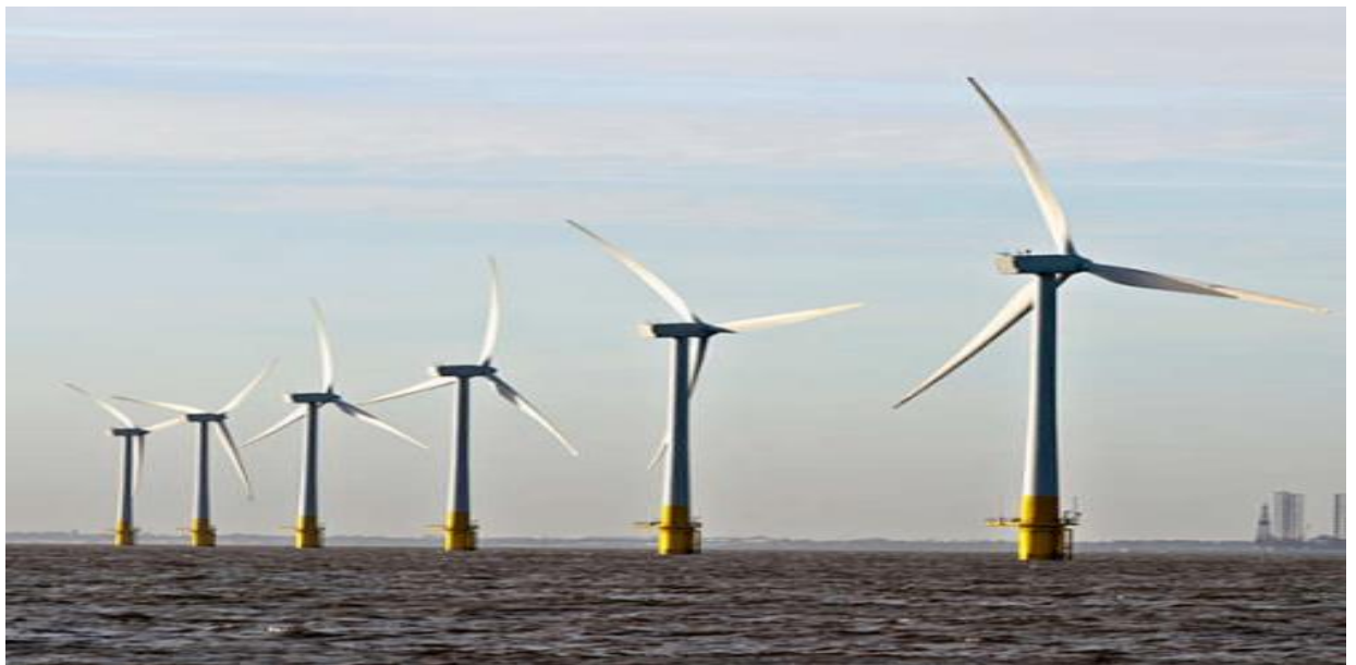
Figure 5: Les éoliennes offshore [5]
