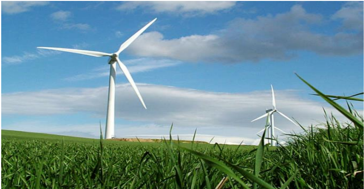
Figure 4: Les éoliennes onshore [4]
