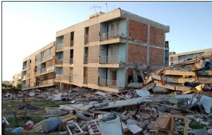
Figure 5 Séisme de Boumerdes 2003
