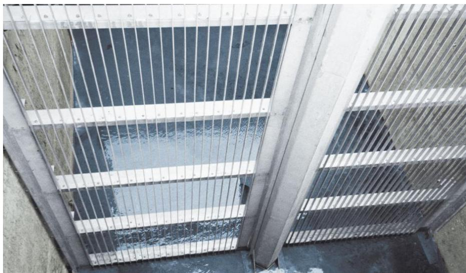
Figure II.3 : Photo d'un dégrillage grossier [33]
