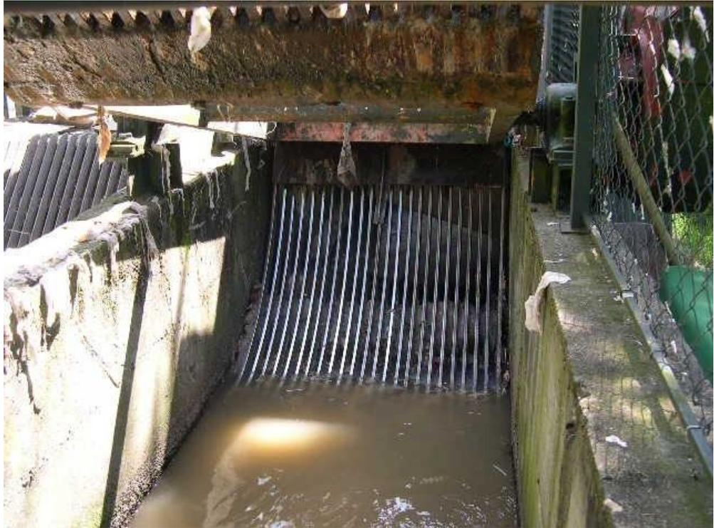
**Figure II.7** : Photo d'une grille courbe [39]
