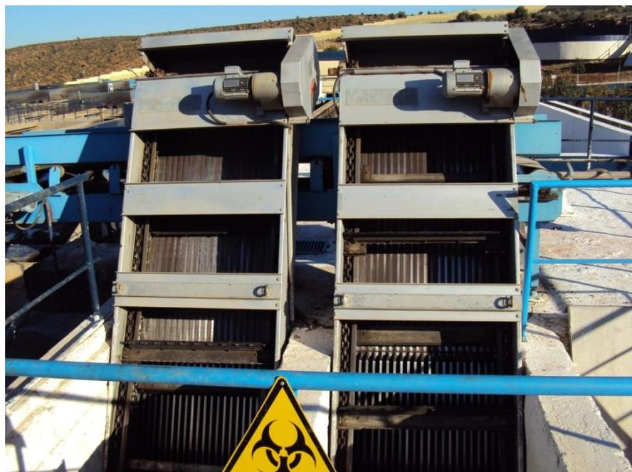
**Figure II.6 :** Photo d'une grille droite [38]
