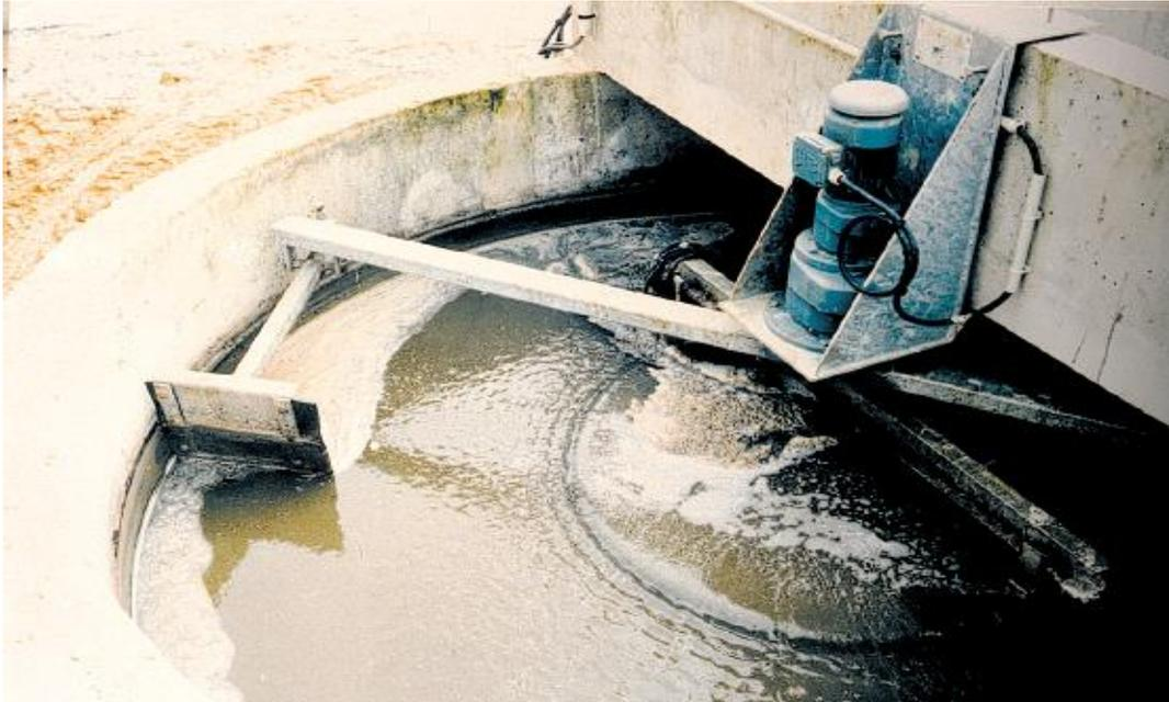
**Figure II.9 :** Photo d'un déshuileur aéré utilisé dans l'épuration des eaux usées [42]
