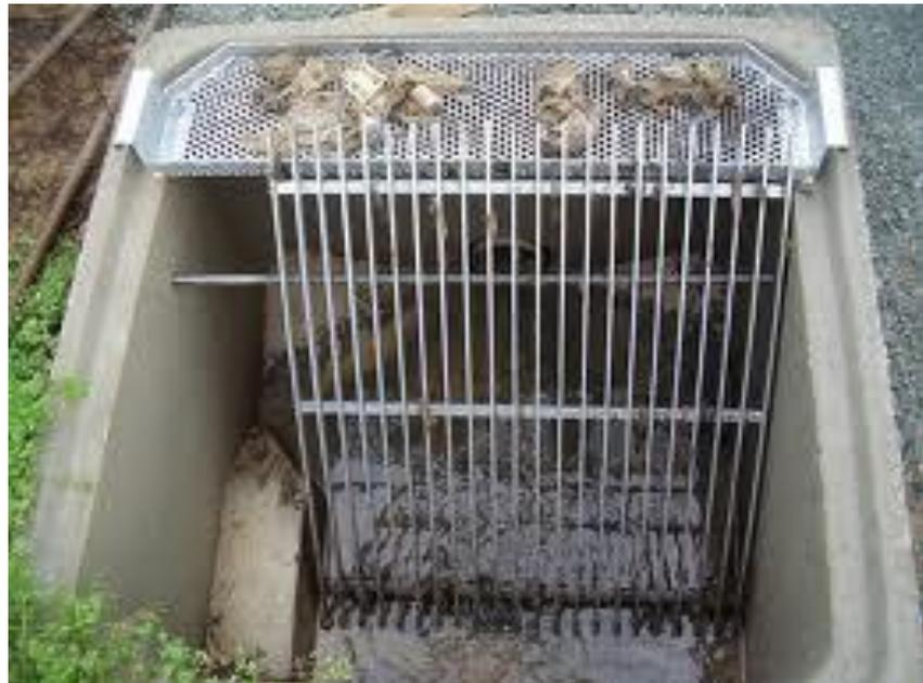
**Figure II.5 :** Photo d'une grille manuelle [36]
