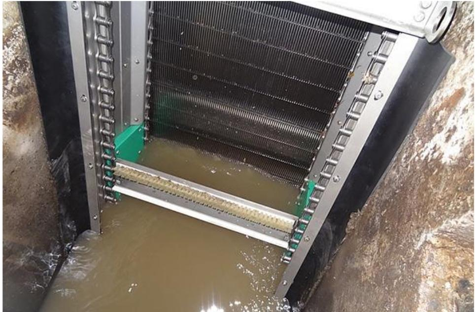
**Figure II.4** : Photo d'un dégrillage fin [34]
