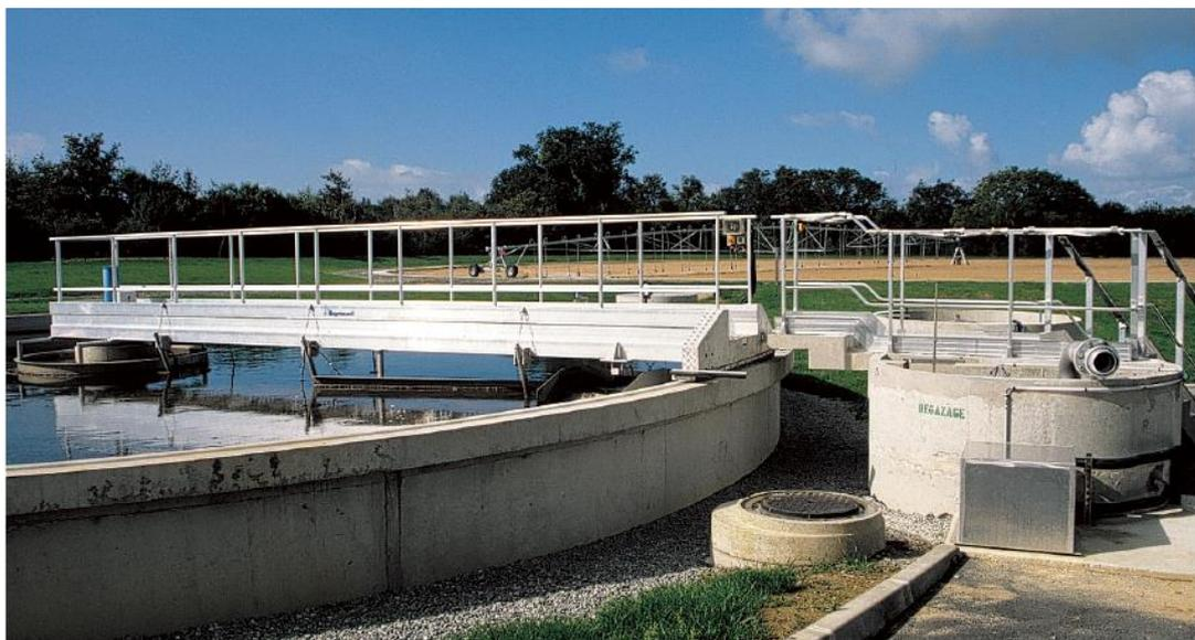
**Figure II.10:** Photo d'un décanteur primaire [44]
