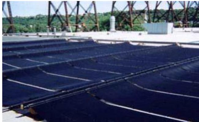
**Figure II.1** Les capteurs plans sans vitrage
