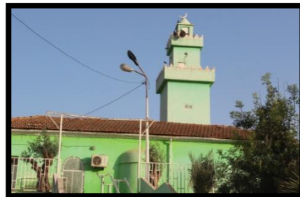
الصورة 23: الواجهة الجنوبية الشرقية
