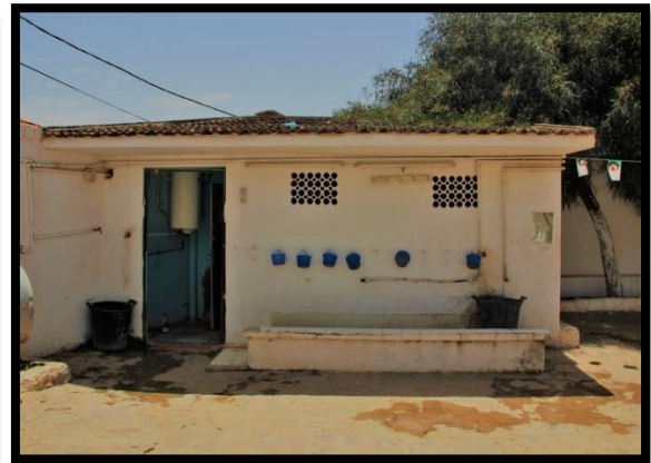
الصورة 110 : ميضأة زاوية القيطنة.
