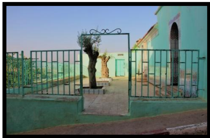
الصورة 24: الواجهة الشرقية
