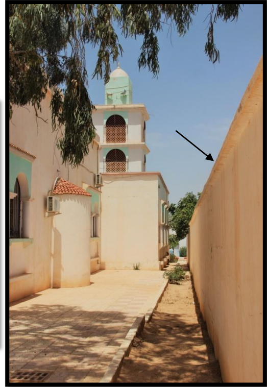
الصورة 87 : الواجهة الجنوبية لزاوية القيطنة.
