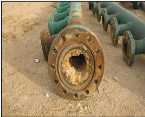
*Photo. 2 : Pipe bouché par les dépôts (Puits BKP2).*
