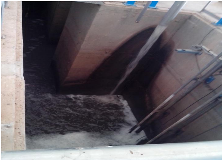
Figure IV.4 : Piège à sable
