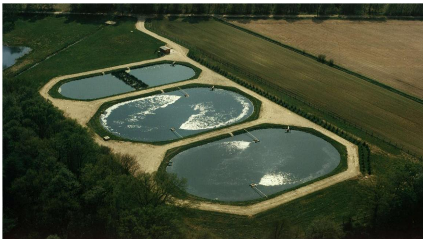
Figure II.9: Bassins de lagunage aéré [24].
