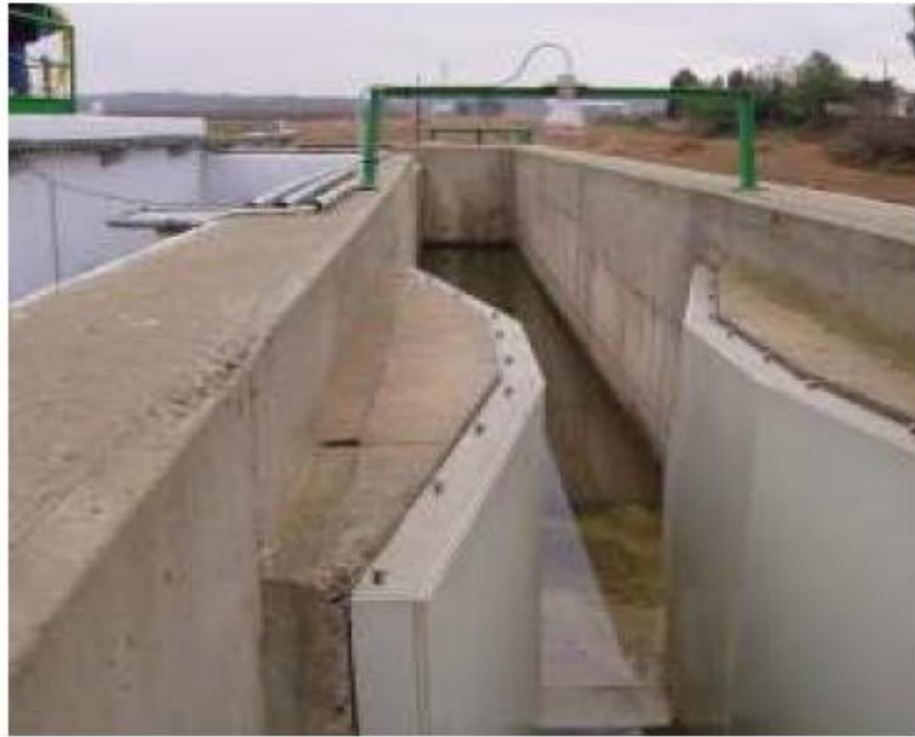
Figure IV.6 : Canal Parshall (mesure du débit)
