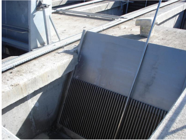
Figure II.2 : Dégriateur à grilles manuelles [16].
