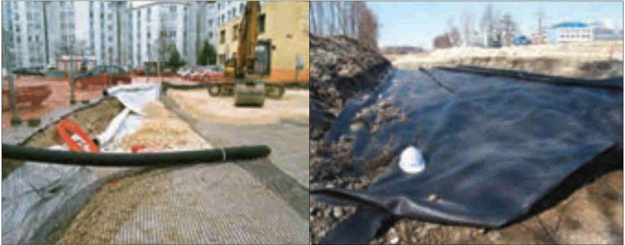
Figure2.12. Utilisation d'un géogrille renforcement de couche de forme
