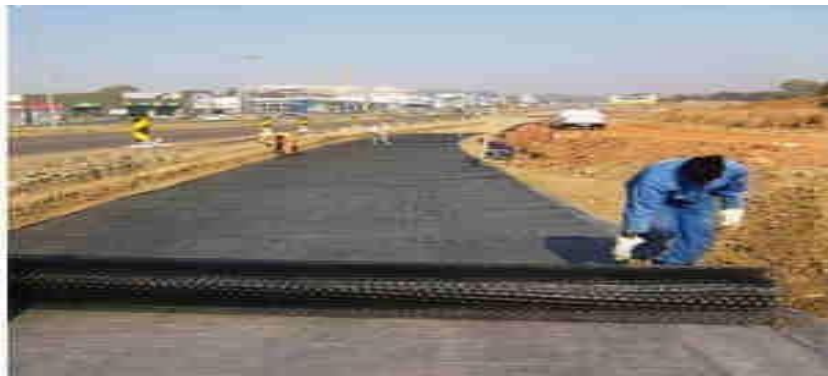
Figure 0.1. Renforcer une route par géo synthétique (moula, 2020)
