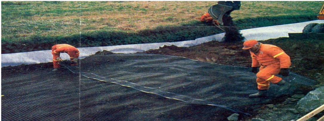
Figure 3.1. Installation de la géo grille de renforcement lors de la réhabilitation d'une route à Vesterålen, Norvège (Watn, 2011, p. 2)
