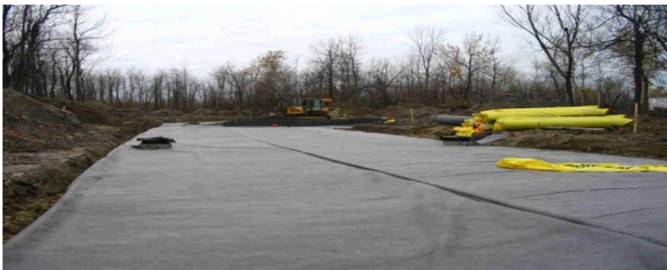
Figure 0. 2. Application de géotextile de renforcement sur sol de faible résistance(dupont & mlynarek, 2019)
