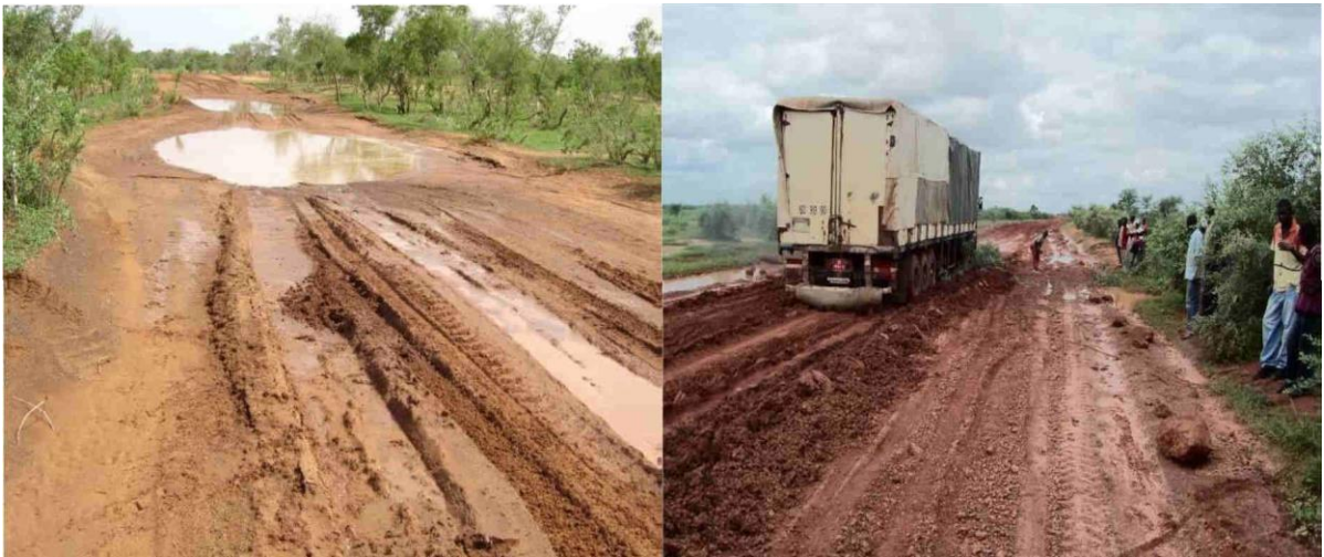
Figure 1.28. Dans les zones affaissées de la route et sur une couche de roulement compactée affaissées de la route. (Illustrations photographiques Planche 6)
