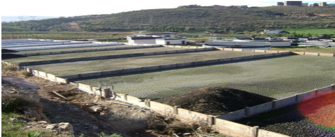
Figure 3.13 : Photo des lits de séchage. [26]
