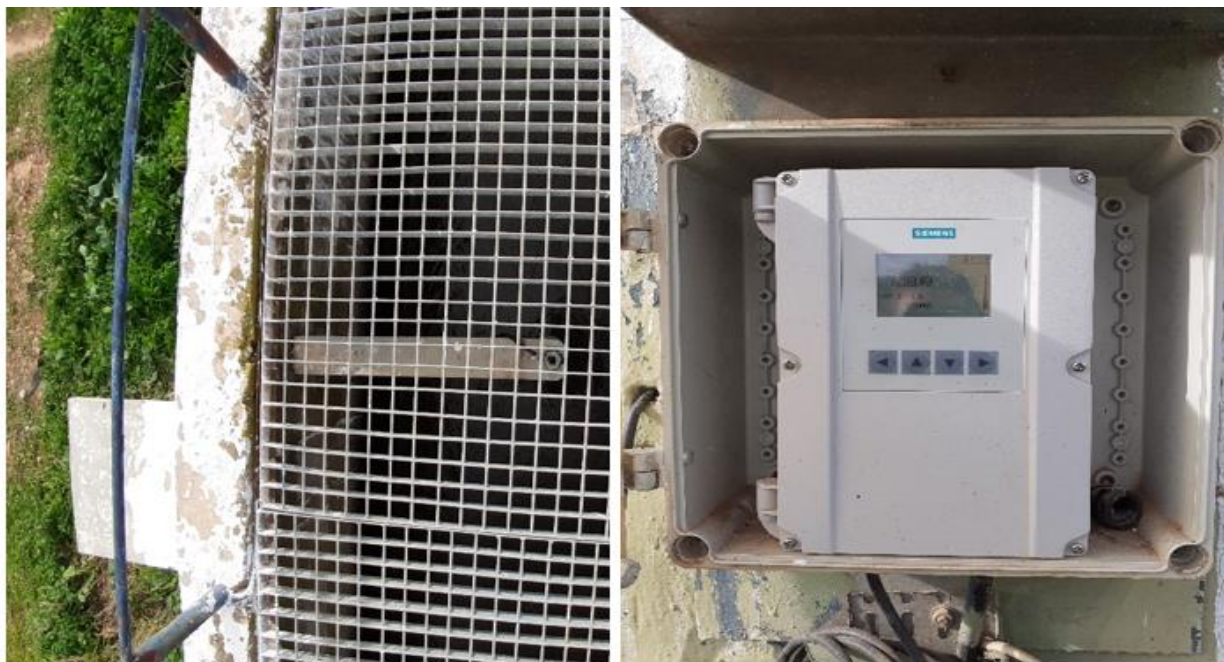
Figure 4.7. : Vue de l'emplacement du débit-mètre Ultra-son
