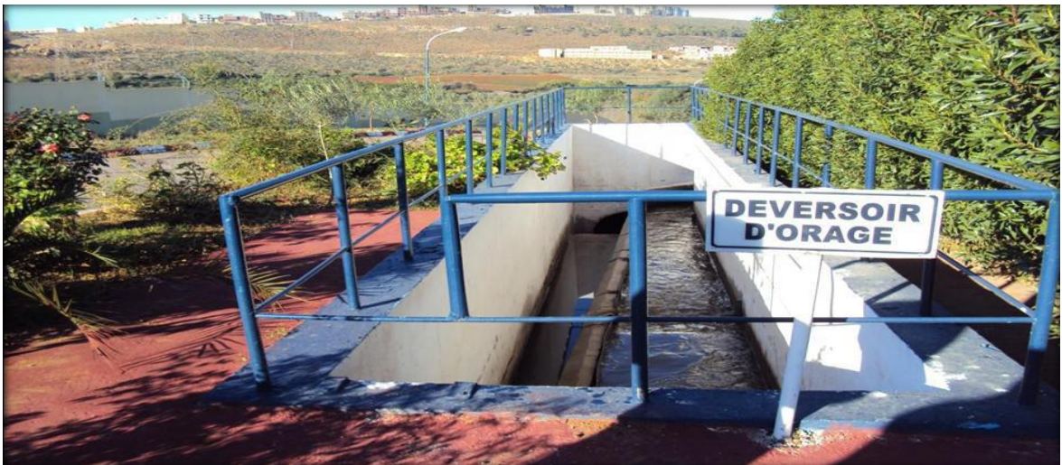
Figure 3.3. : Photos de déversoir d'orage
