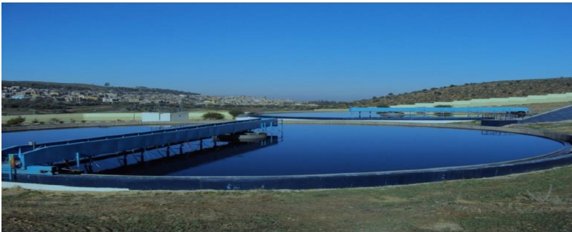
Figure 3.9 : Photo du décanteur secondaire
