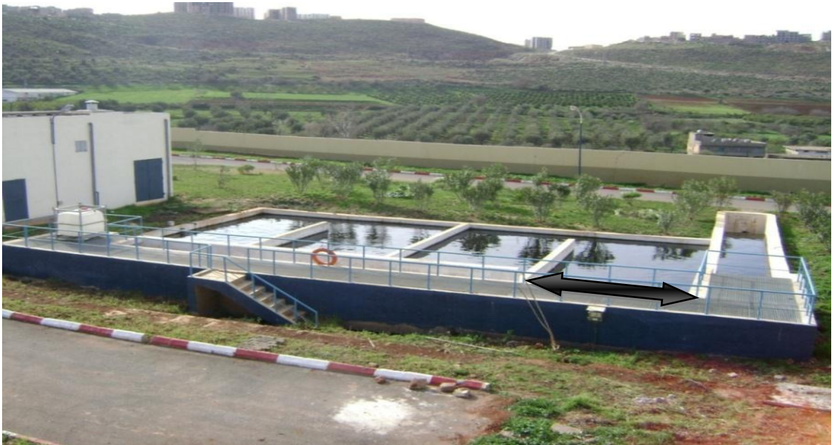
Figure 3.16 : l'emplacement du venturi dans la station d'épuration Ain El Houtz
