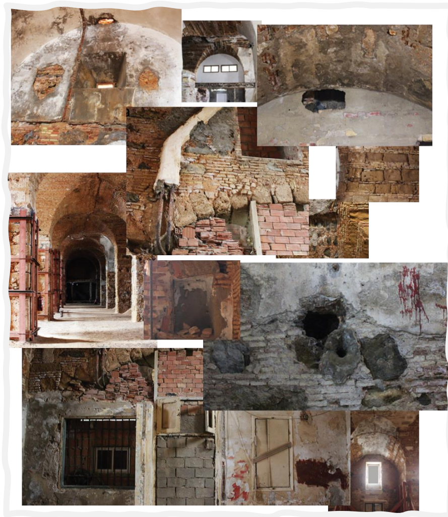
Figure 45 photo prise par l'auteur des pathologies des voutes Khair-Eddine
