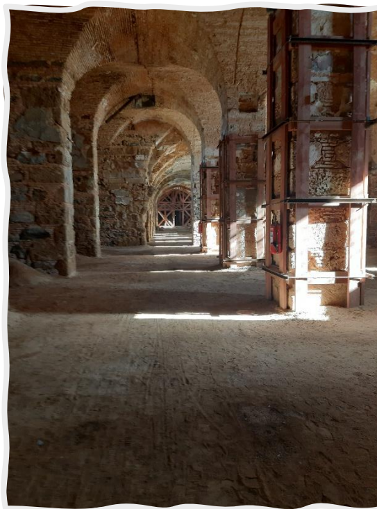
Figure 63 photo de la structure des voutes prise par auteur
