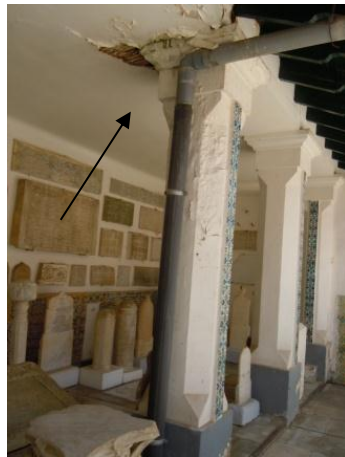
الصورة رقم (229): تلف سقف صحن القسم القديم. الصورة رقم (230): تلف الصحن سقف القسم القديم.
