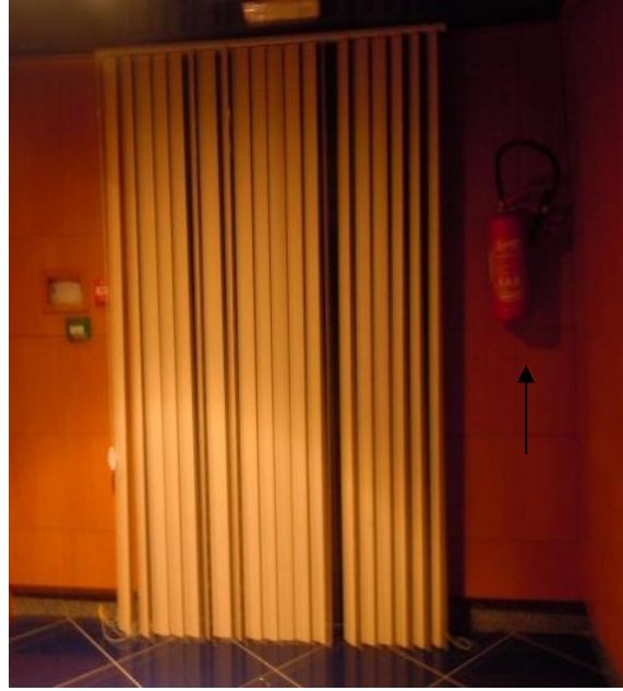
الصورة رقم (327): استخدام قارورة الاطفاء في الطابق الاول.
