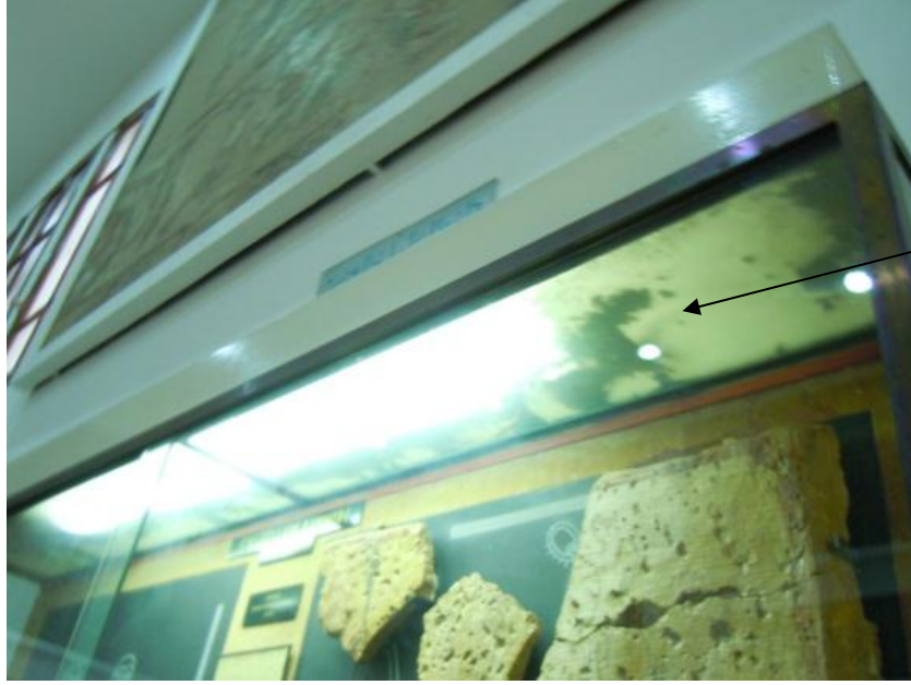
الصورة رقم (270): تراكم الاتربة بقسم الاضاءة باحدى واجهات قاعة العبادات الوثنية .
