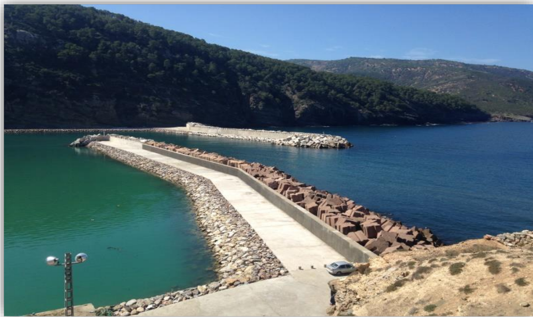
Figure 6: Jetées principale et secondaire du port de Honaine (photo originale)
